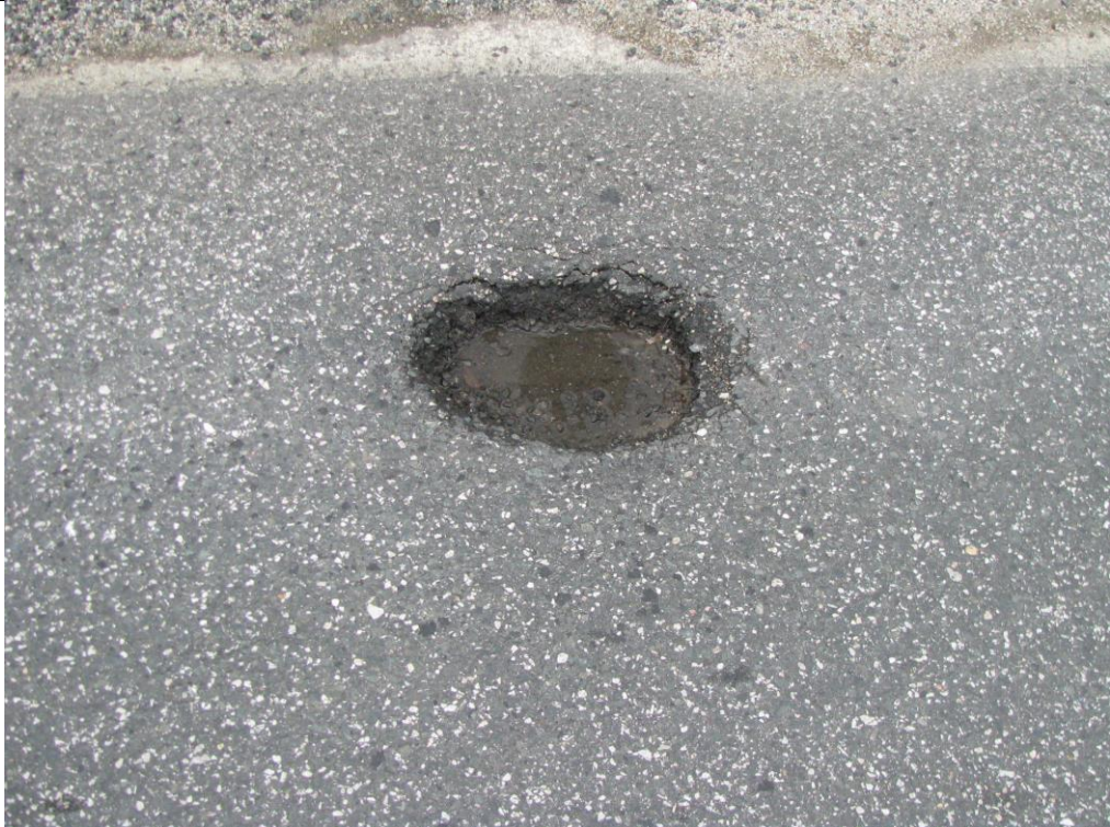
Слика 1. Ударне рупе на коловозу
