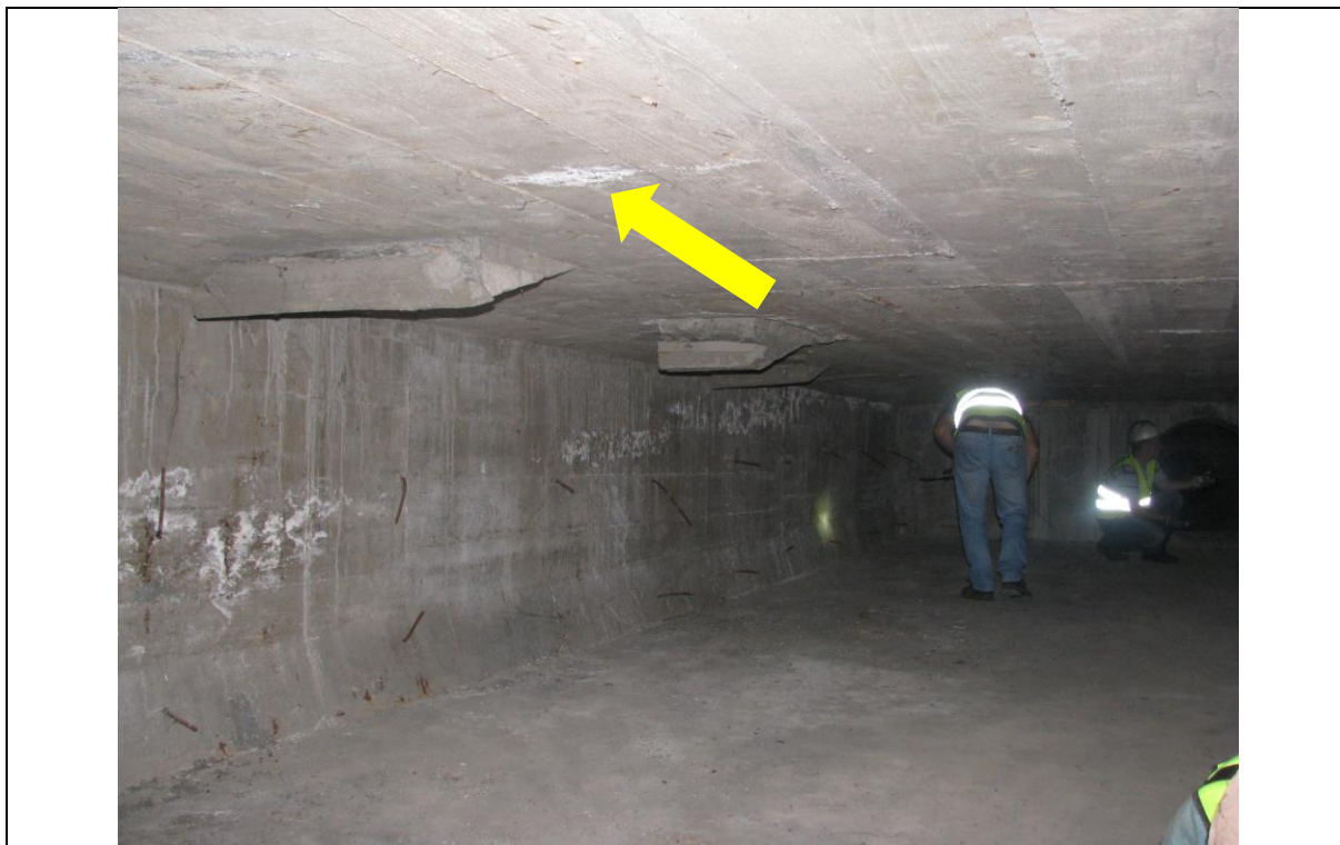
Слика 5. Калцификација у коловозној плочи. Конструкција К-1. Калцификација у коловозној плочи се јавља и на конструкцији К-2.
