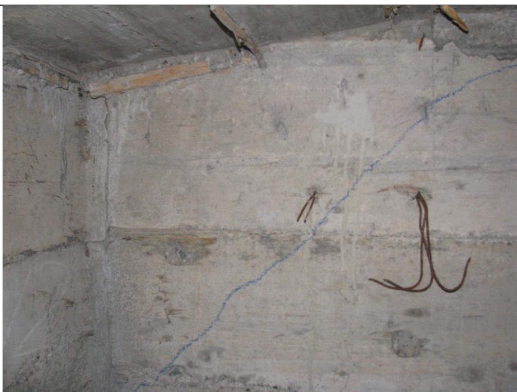
Слика 22. Прлина на секундарном попречном носачу у пољу С6-С7. Конструкција К-2.
