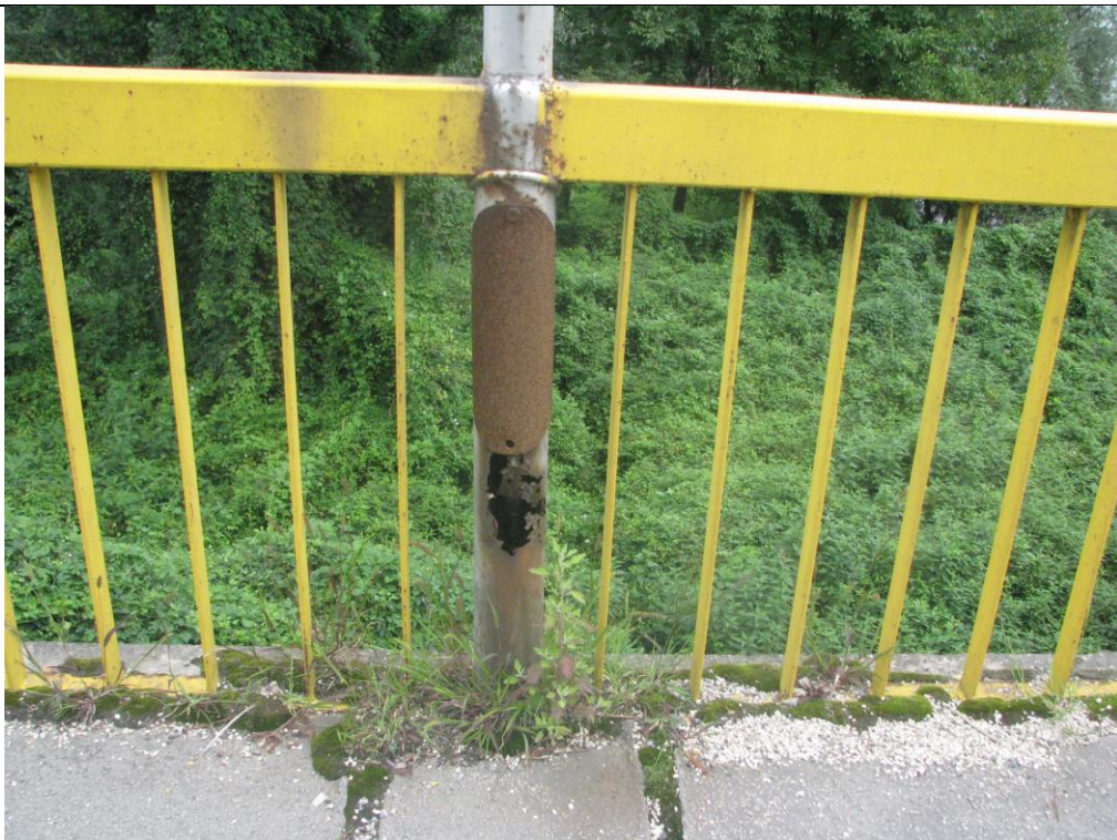
Слика 4. Карактеристично стање стубова електро расвете. Корозија и значајно смањење носећег пресека стуба.
