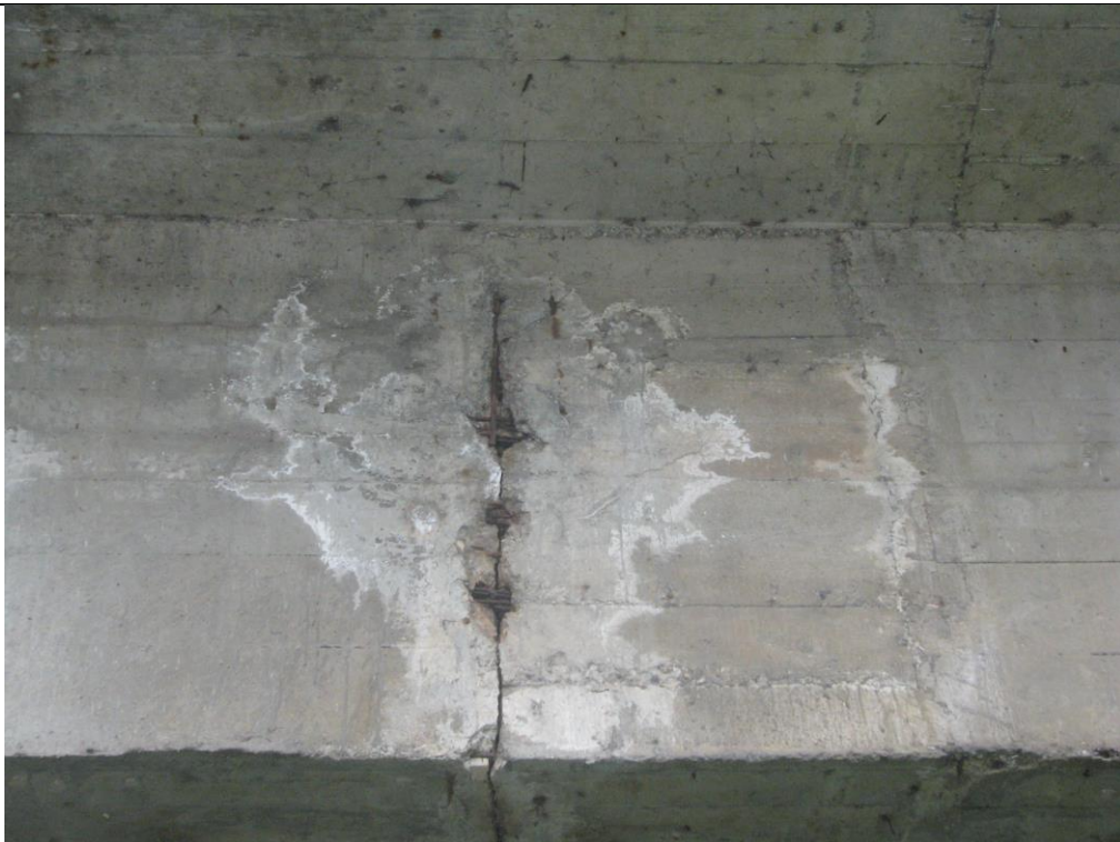
Слика 16. Пукотина у ребру сандука целом висином ребра. Поље С2-С3. Конструкција К-1, поглед са спољашње стране.
