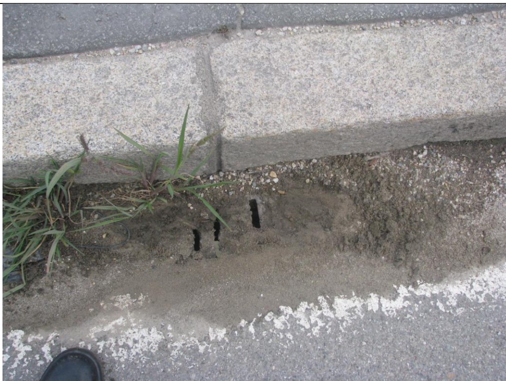
Слика 31. Сливничке решетке делимично затворене чиме је коректно одводњавање онемогућено.
