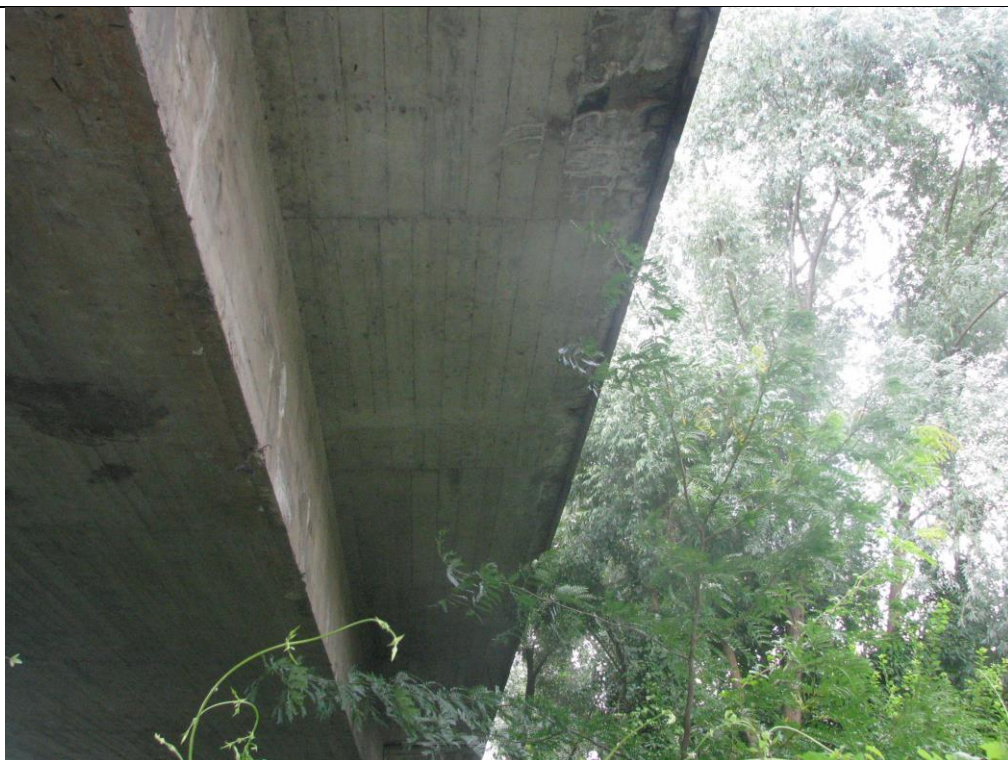
Слика 23. Трагови процуривања и калцификације на конзолама коловозне плоче
