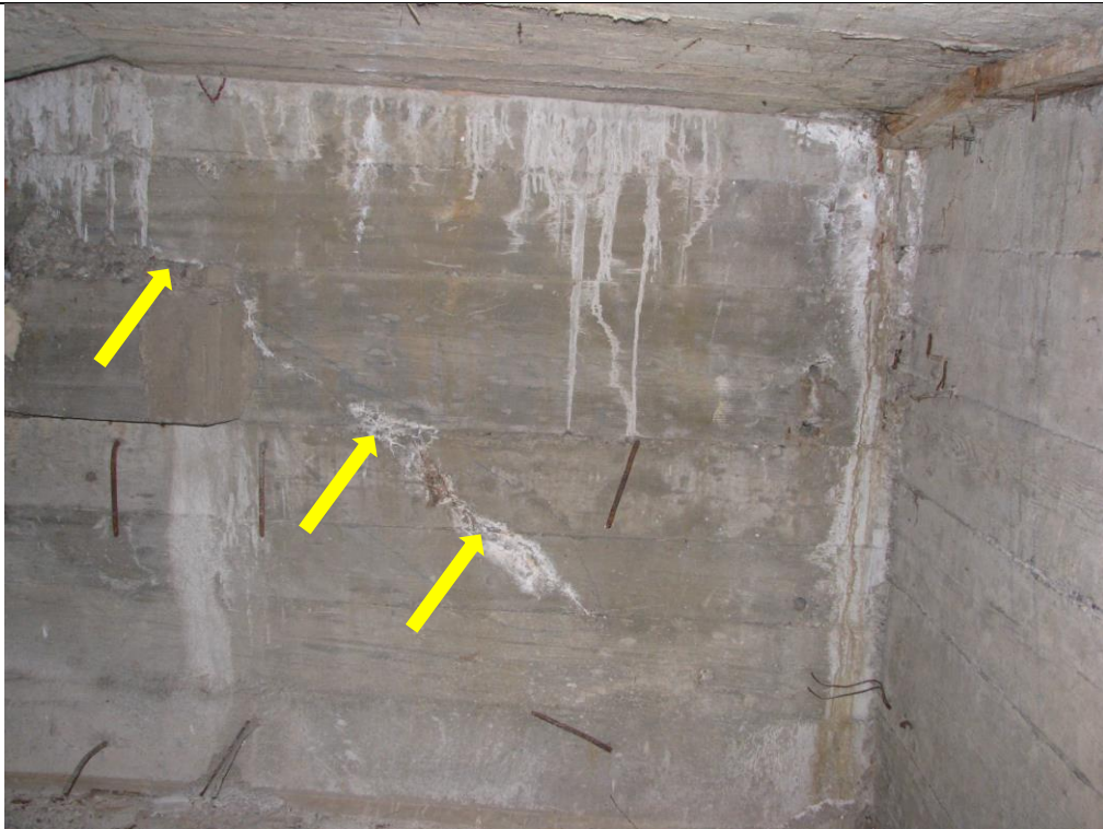
Слика 17. Прлина у ребру главног носача. Поље С4-С5. Низводно ребро. Конструкција К-2.
