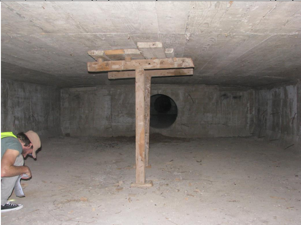
Слика 8. Заостала оплата на коловозној плочи сандука. Конструкција К-1
