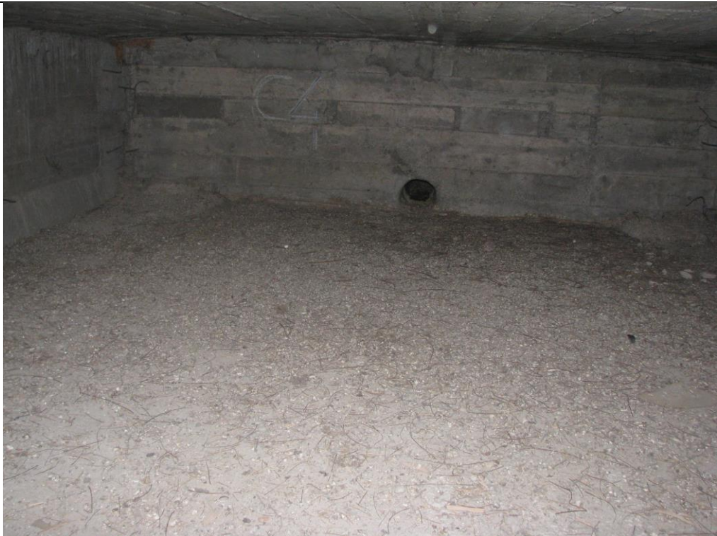
Слика 13. Нечистоћа на доњој плочи главног носача. Поље С4-С5. Конструкција К-2.
