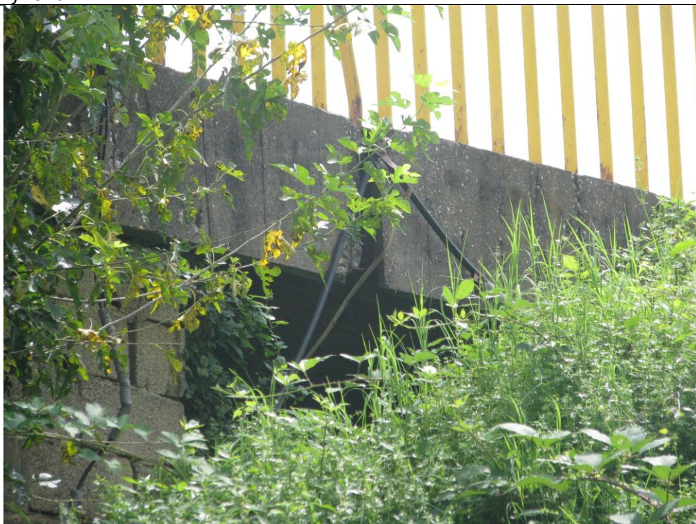
Слика 32. Инсталације некоректно вођене на месту обалног стуба С8.
