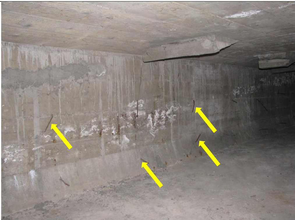
Слика 14. Калцификација у ребрима сандука у зони каблова за преднапрезање и заостали арматурни анкери у ребрима сандука.
