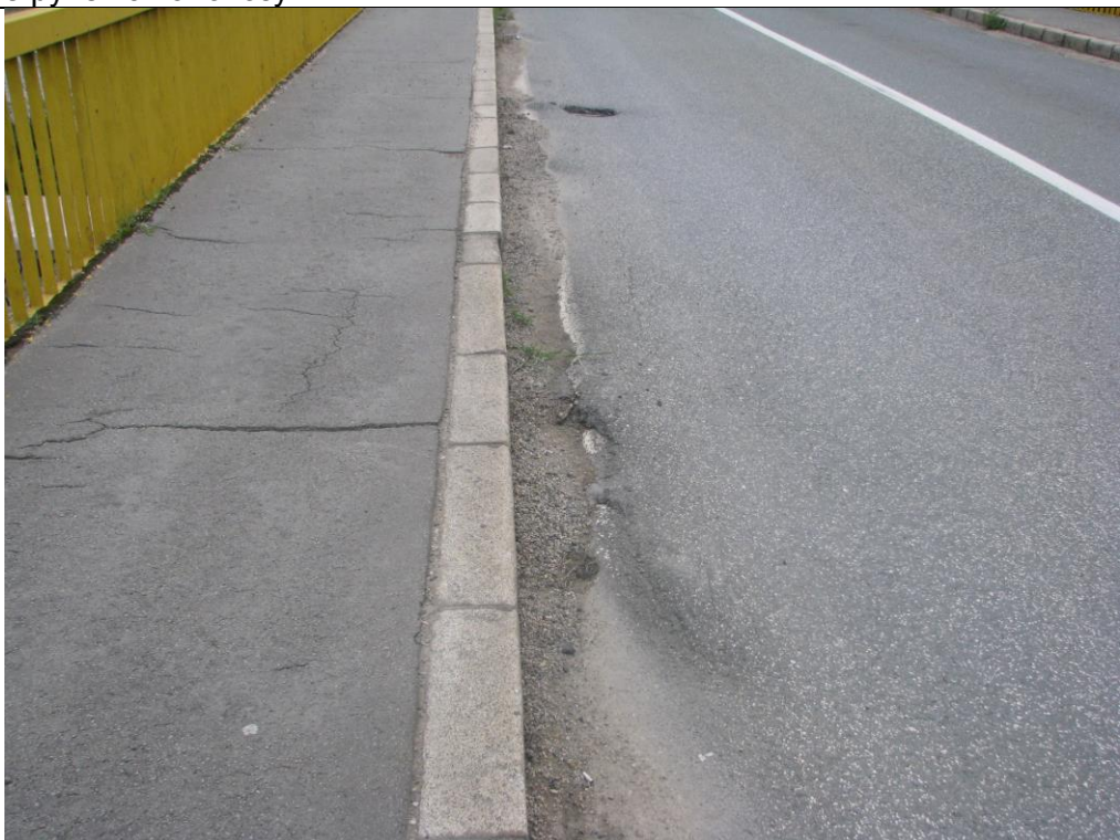
Слика 2. Подужне и попречне прслине на асфалу пешачке стазе као и видне деформације на асфалу коловоза.
