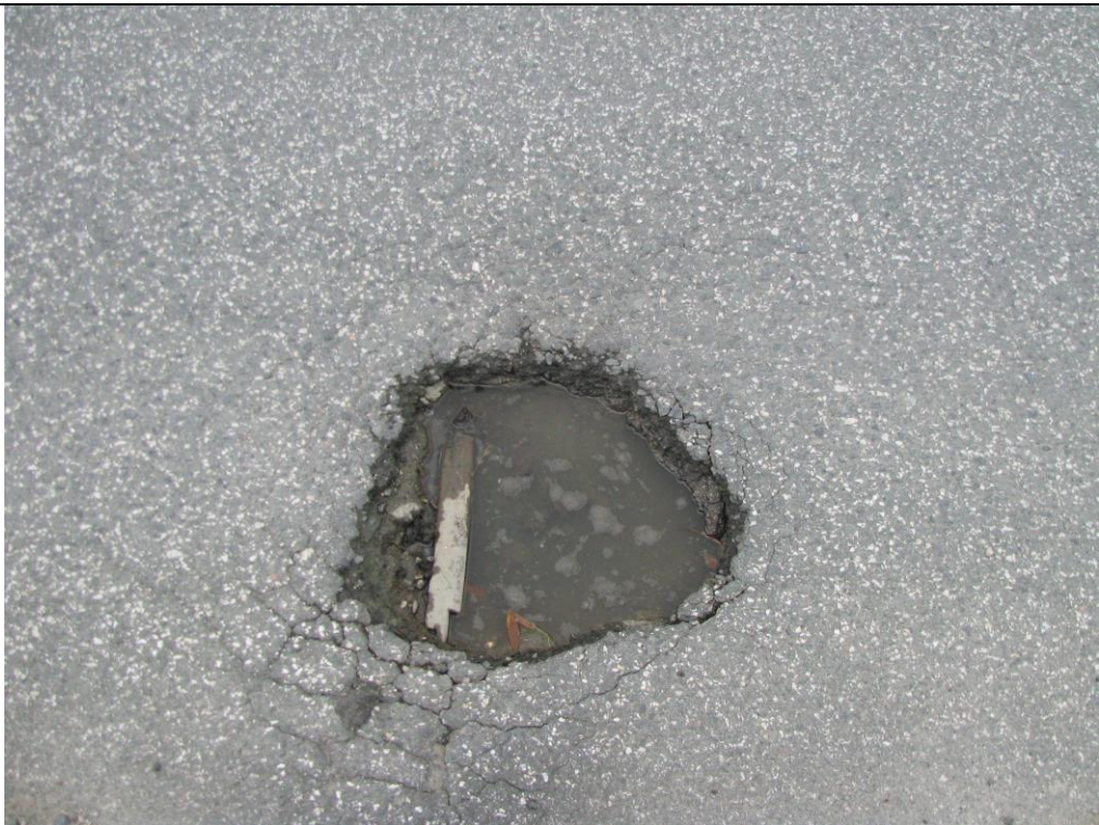
Слика 1. Ударне рупе на коловозу.
