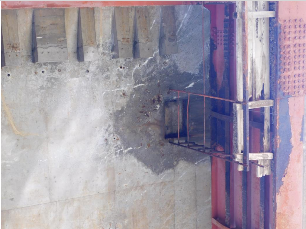
Слика 11. Процуривање и калцификација у зони око ревизионог отвора коловозне плоче.
