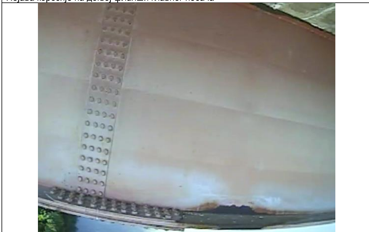
Слика 6. Појава корозије на доњој фланши главног носача
