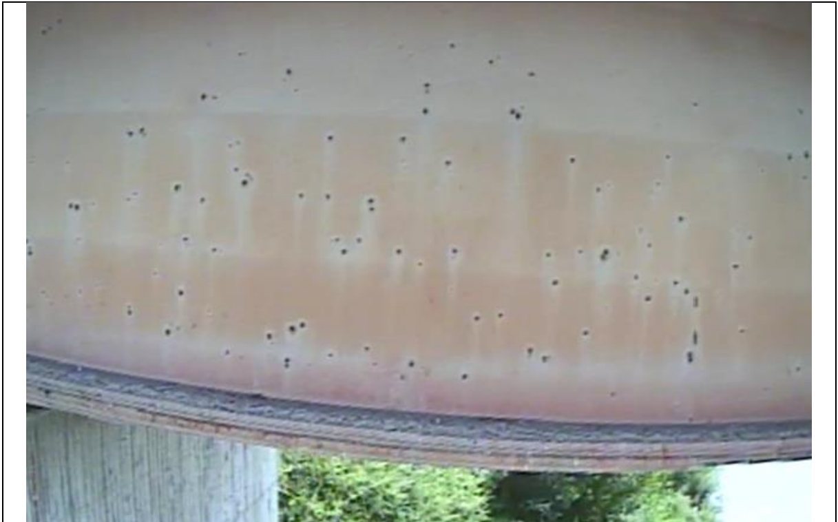
Слика 7. Тачкаста корозија на ребру главног носача
