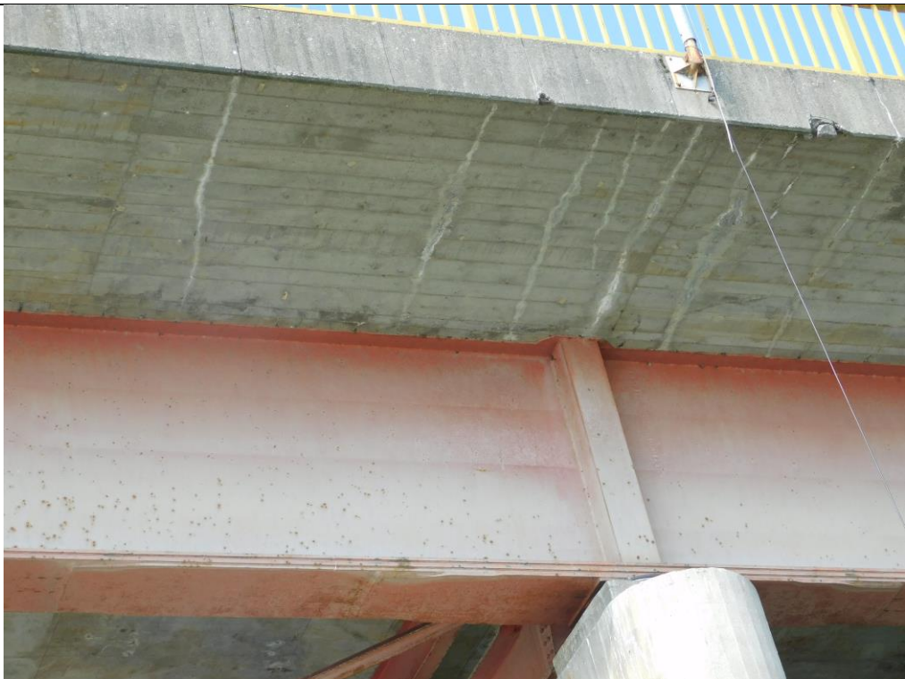
Слика 10. Попречне прлине са траговима калцификације на конзолама коловозне плоче у зони изнад стуба
