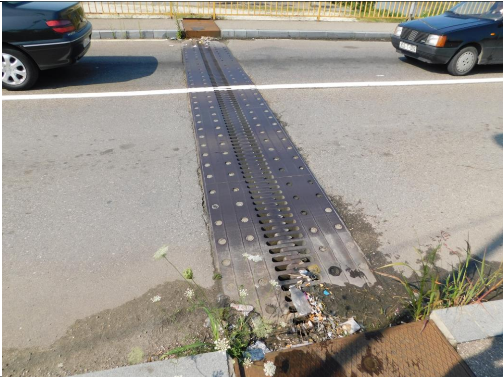
Слика 15. Дилатационе справе у функцији, али са нечистоћама израженим уз ивичњаке.
