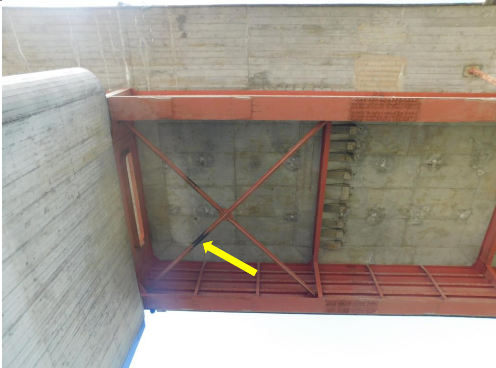
Слика 12. Трагови корозије на спрегу главног носача.
