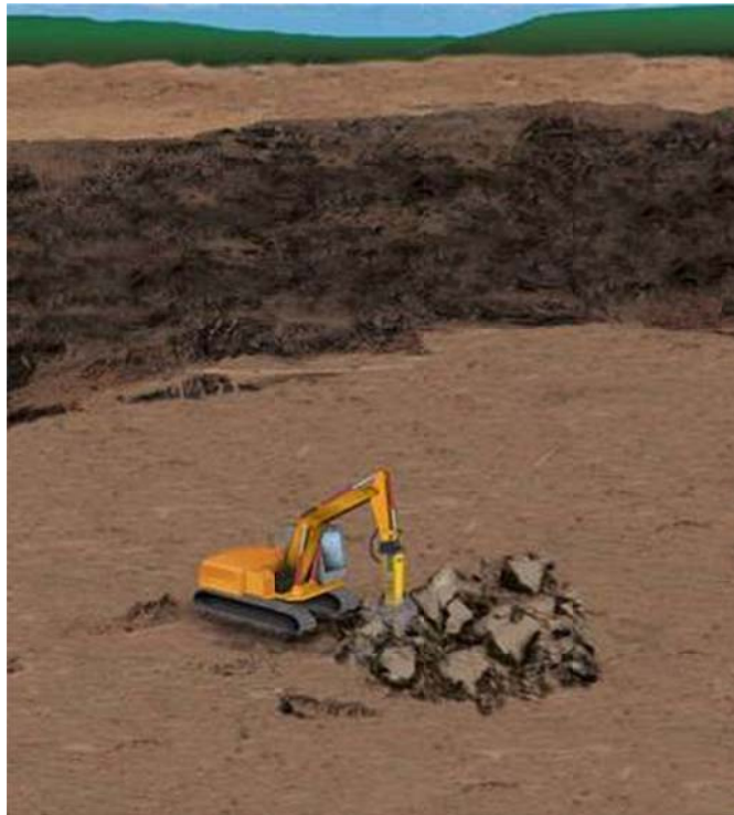
Slika 2.3. Usitnjavanje negabarita mehaničkim udarnim čekićem
