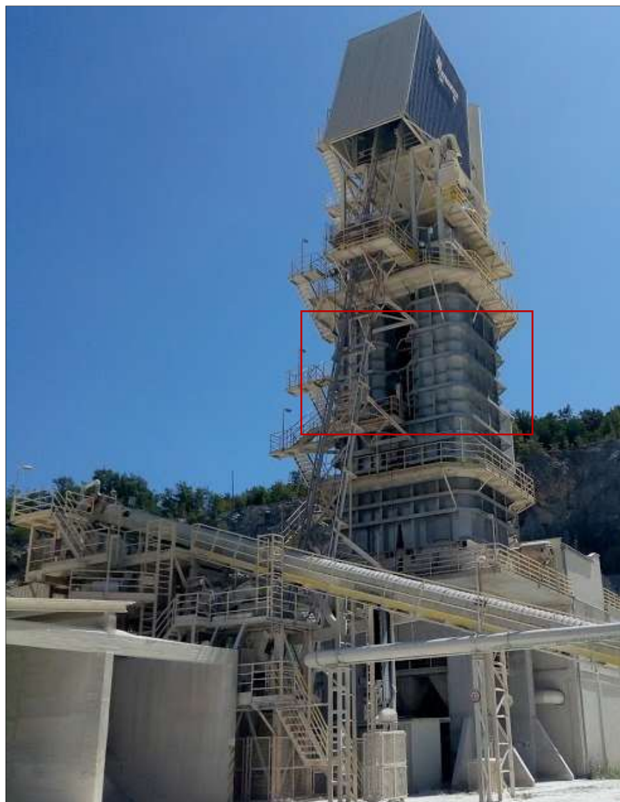
Slika 8. – Krečna peć sa označenim delom na kome se planira dogradnja nove platforme
