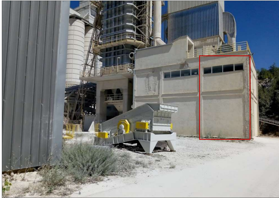
Slika 12. – Zgrada duvaljki sa označenim delom koji se adaptira za potrebe priključenja silosa
