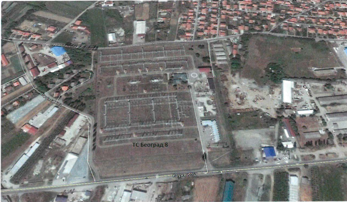
Сателитски снимак локације ТС 400/220 kV Београд 8
