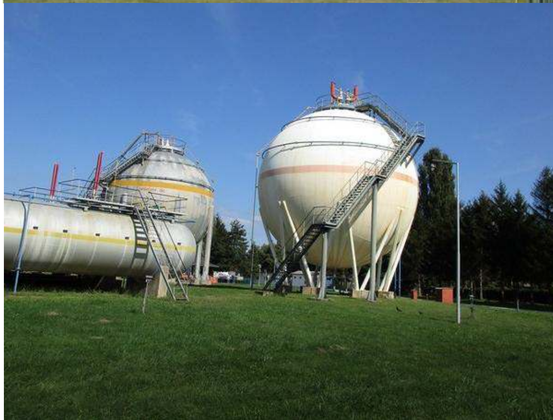
Slika 3.0. Izgled skladišnih rezervoara za TNG
