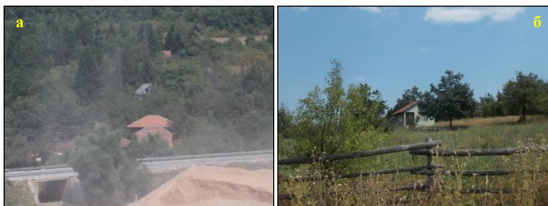
Слика 10. – Грађевински објекти сеоских домаћинства на растојањима: а) 135 m североисточно, б) 145 m југозападно
