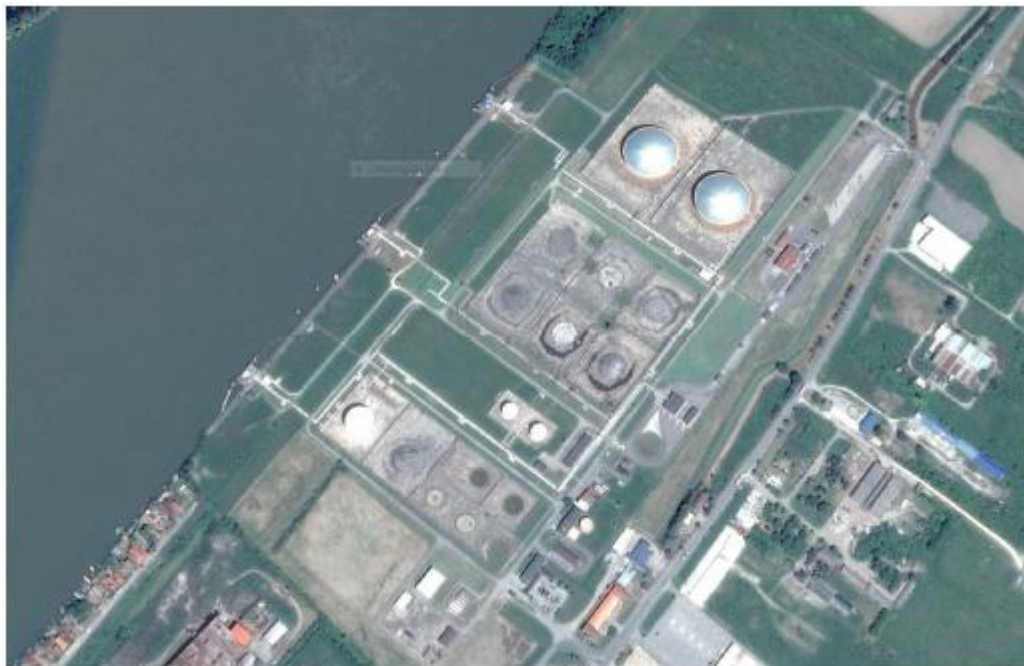
Slika 3.0.1. Postojeće stanje Skladišta naftnih derivata Smederevo (pogled iz vazduha)
