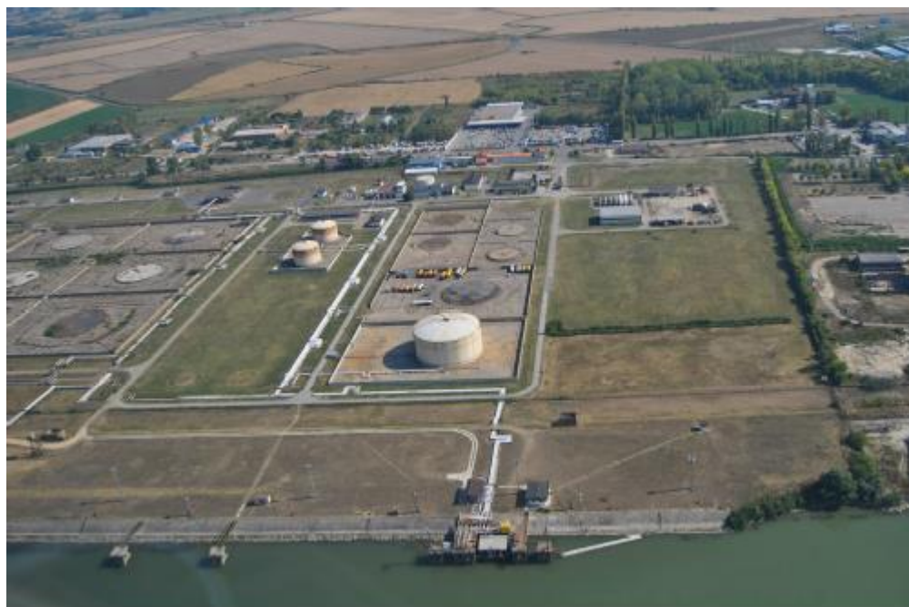
Slika 3.0.2. Postojeće stanje Skladišta naftnih derivata Smederevo (pogled sa desne obale reke Dunav)
