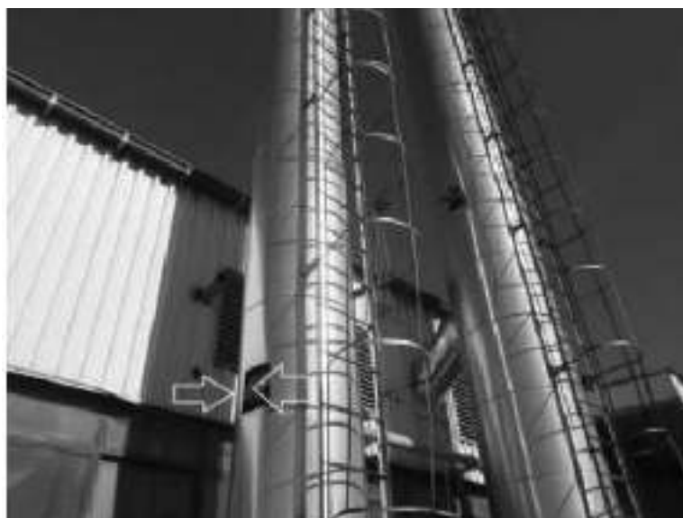
Slika 40. Merna mesta na emiteru parnog kotla
