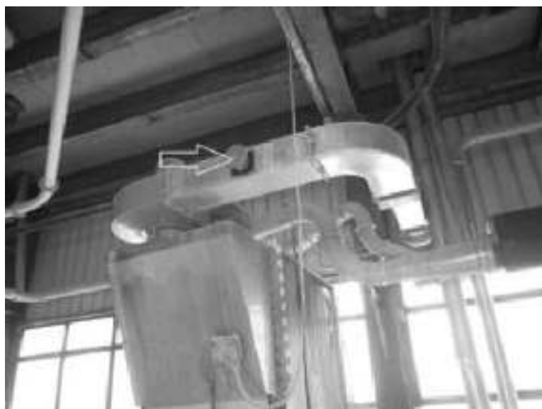
Slika 53. Merno mesto na emiteru filtera F8104
