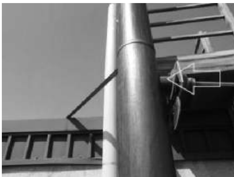
Slika 66. Merno mesto na emiteru sistema ventilacije sa miksera i linije BREF - TORNADO
