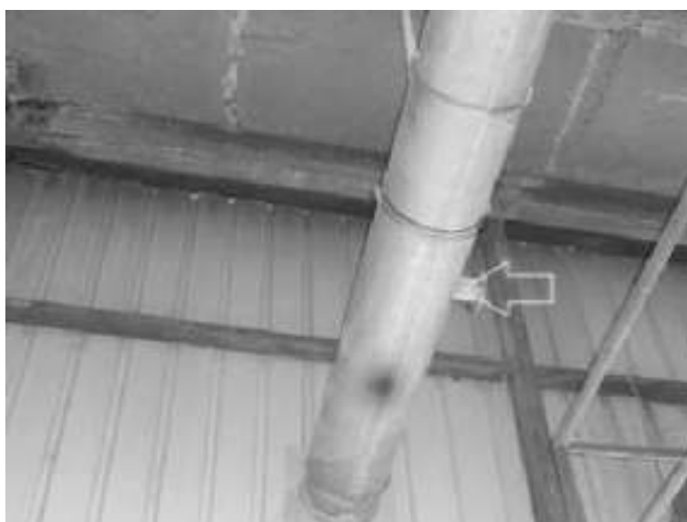
Slika 56. Merno mesto na emiteru filtera F8109
