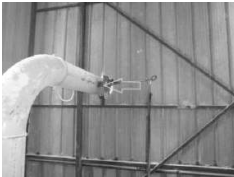
Slika 47. Merno mesto na emiteru filtera F12
