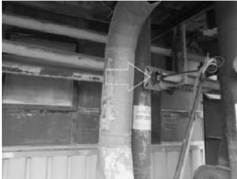
Slika 49. Merno mesto na emiteru filtera F1507
