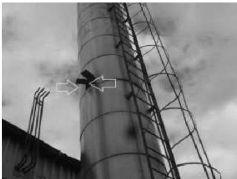
Slika 41. Merna mesta na emiteru toplovodnog kotla
