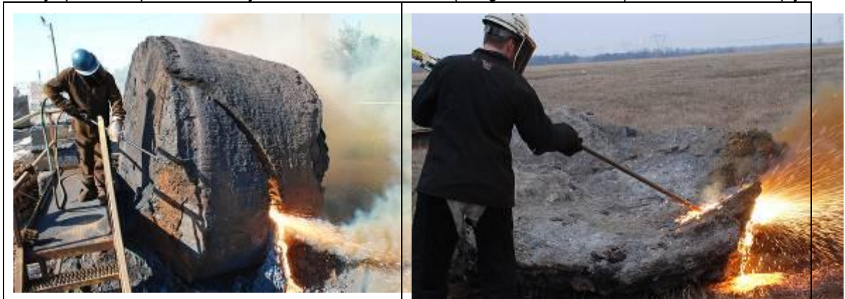
Slika 10. Prikaz kiseoničnog koplja i postupka sečenja velikih komada troske
