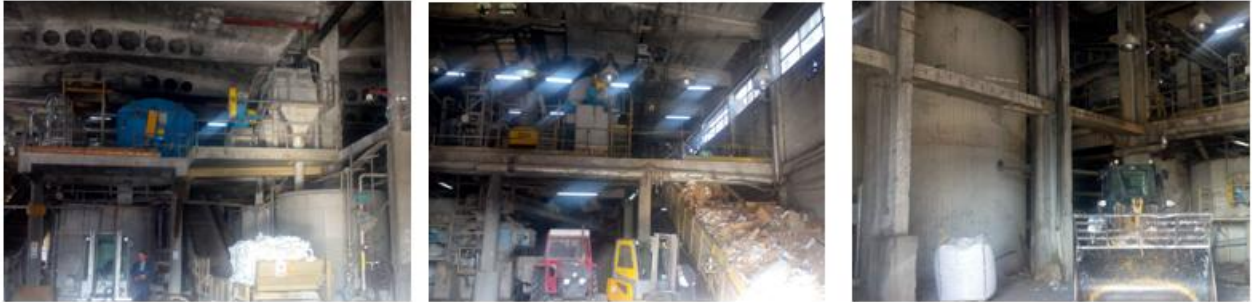
Слика бр. 20: Унутрашњост објекта за припрему масе
