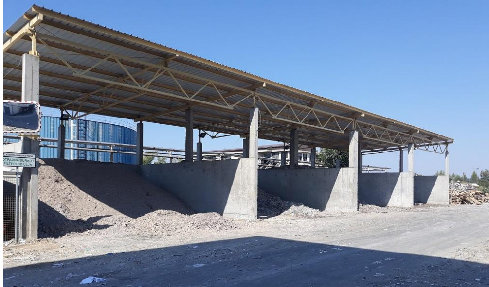
Слика бр.59: Надкривени боксови за технолошки отпад (магазин технолошког отпада)
