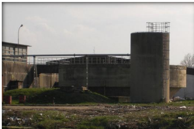
Слика бр. 37: Водоторањ, динамички акцелератор и објекат филтер станице (гледано са десна на лево)
