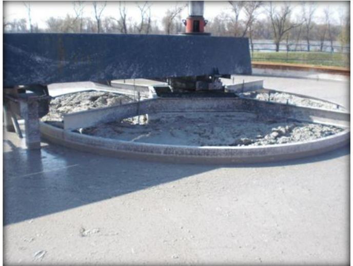
Слика бр. 40: Централни део радијалног коагулатора – сакупљање лаке фракције са површине воде
