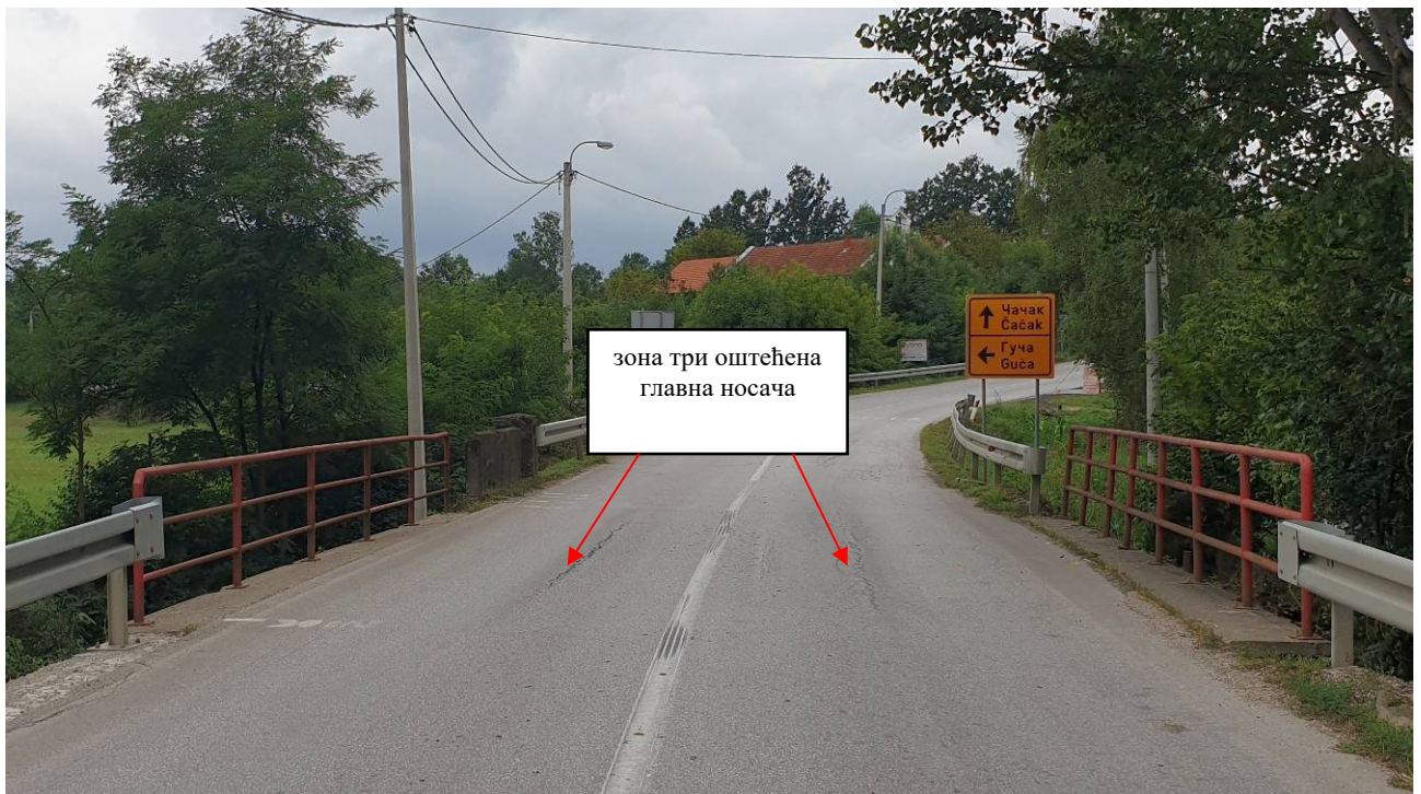
Поглед на мост из правца Краљева
