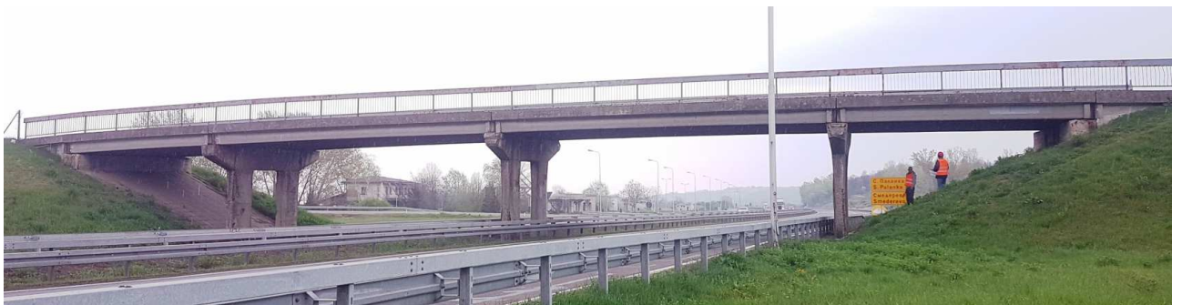
Фотографија бр. 3 - Поглед на надвожњак из правца Београда
