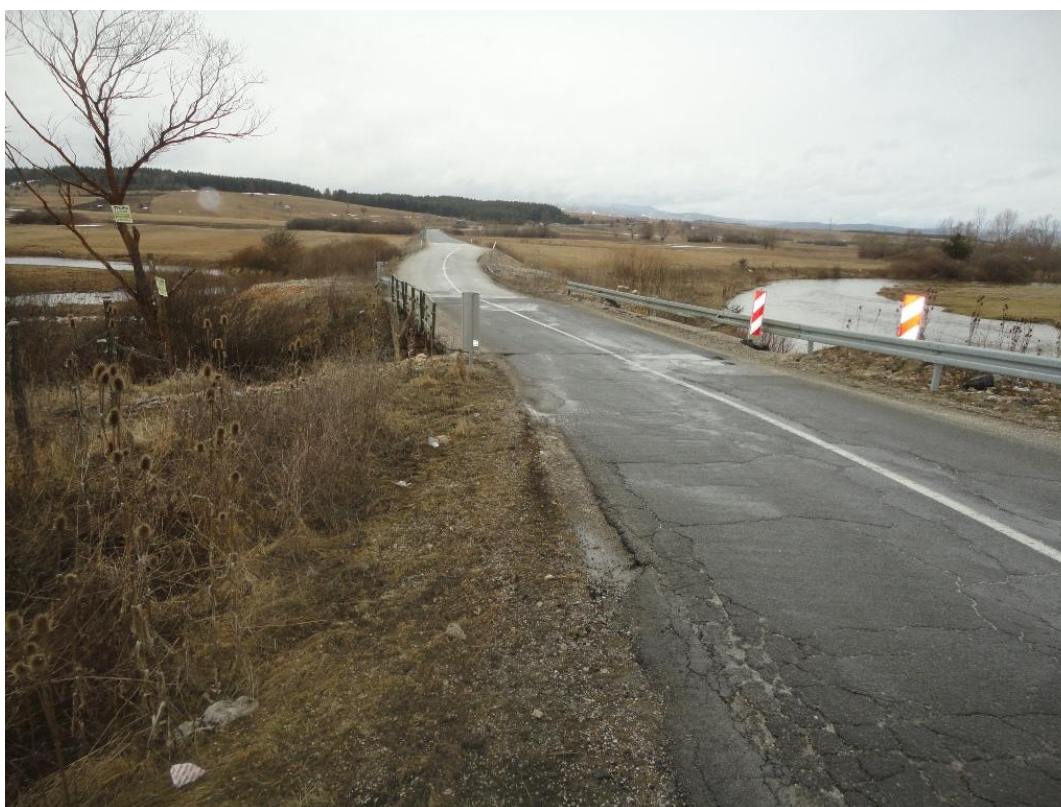
Оштећења асфалта у зони моста
