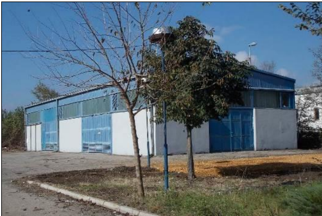
Слика 5. – Изглед постојећег објекта
