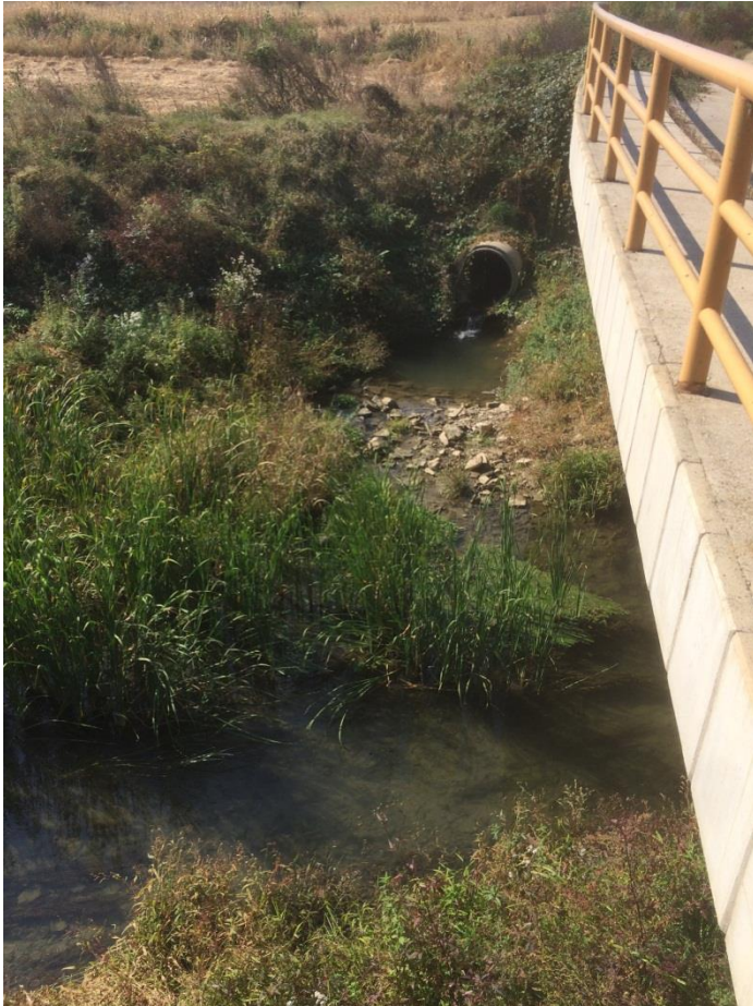
Слика 3 Низводни део моста, где је предвиђено качење цеви
