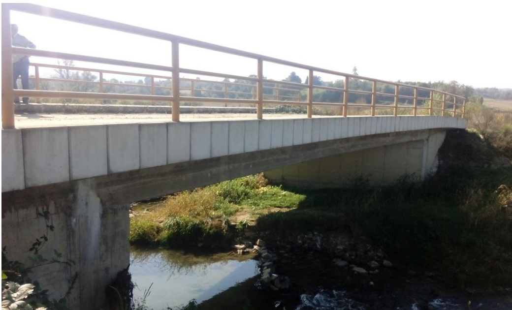
Слика 2 Узводни део моста
