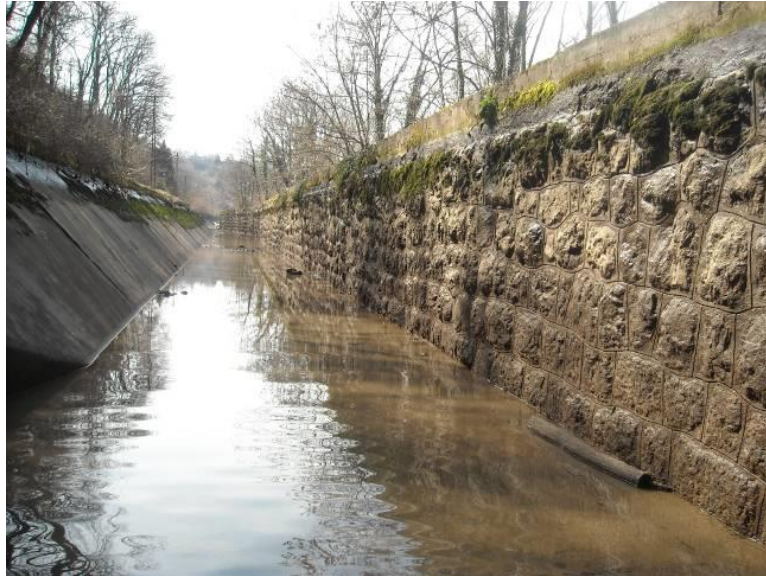
Слика 7. Деривациони канал МХЕ "Сићево"
