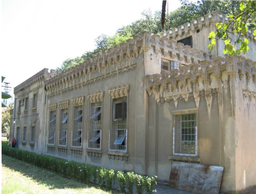
Слика 2. Изглед машинске зграде МХЕ "Сићево"
