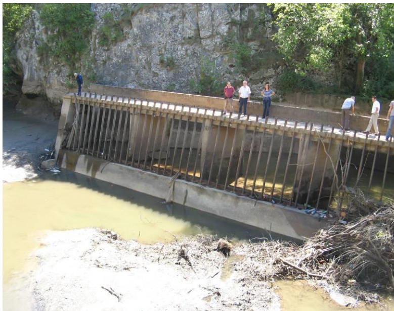
Slika 20.a Ulazna građevina sa grubom rešetkom.
