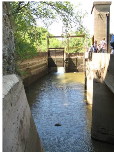
Slika 20.b Taložnica na ulazu u derivacioni tunel.
