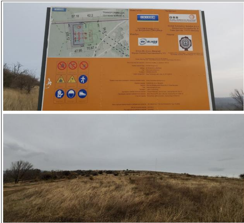
Слика бр. 4: Локација Трансформације „ВЕ Кривача“ и ПРП „Кривача“ на Голем Брду (И.Тошић, октобар 2019.)
