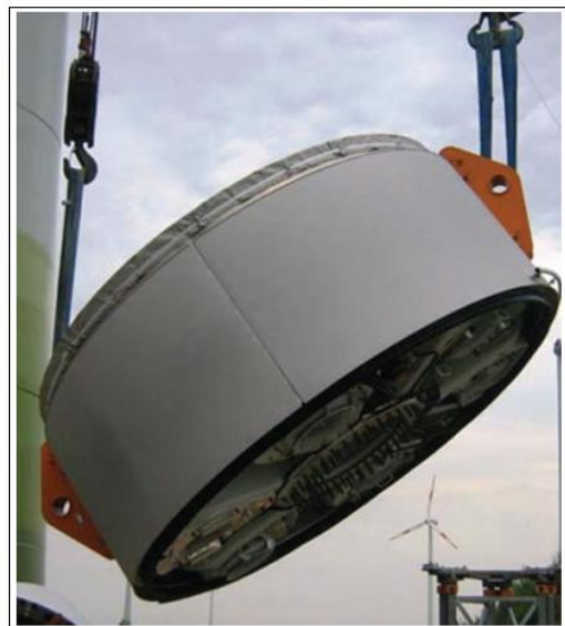
Слика бр. 73: Монтажа гондоле
