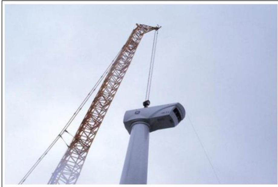
Слика бр. 74: Дизање генератора
