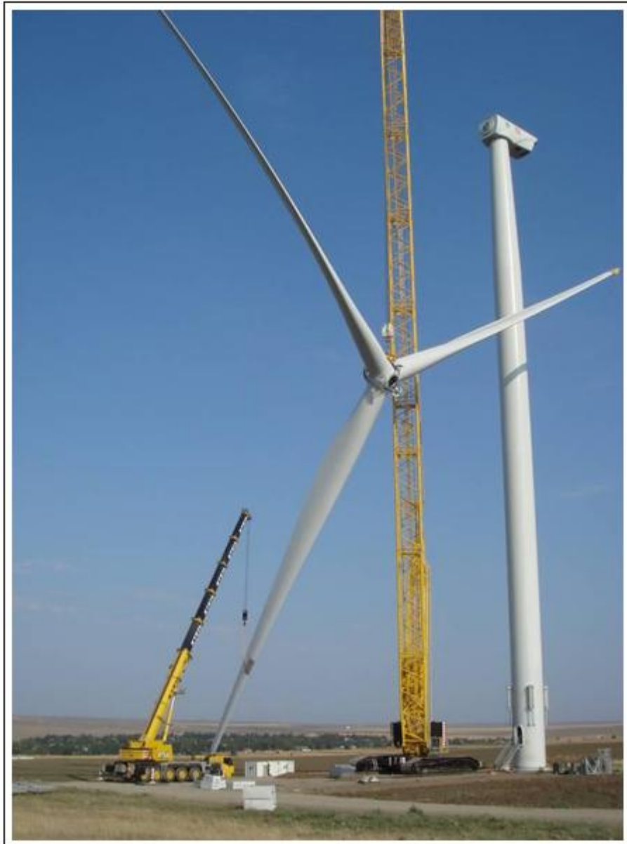
Слика бр. 75: Монтажа скопљеног чворишта и лопатица на стуб ветрогенератора
