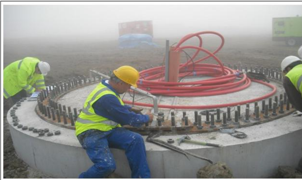
Слика бр. 71: Изведена темељна конструкција
