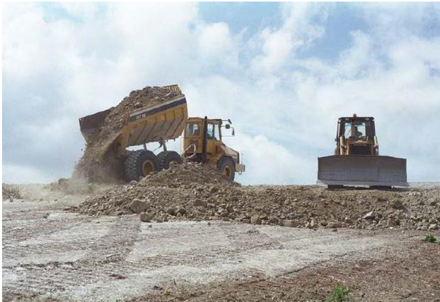
Слика 3.5.3-1. Прекривање отпада слојем инертног материјала
