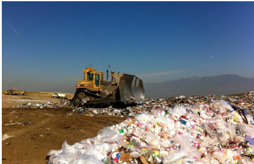
Слика 3.5.2-1. Разастирање отпада по завршеном истовару
