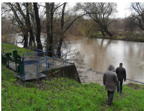
Слика бр. 11: Водозахват на реци Нишави
