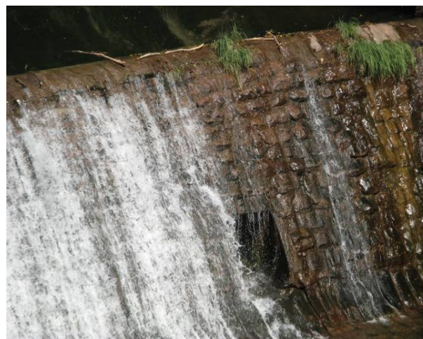
Slika 3.4 Otvor kroz telo brane
