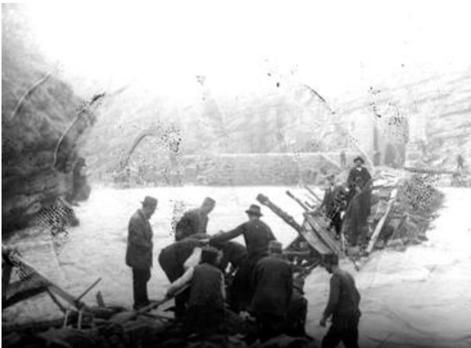
Slika 2.4 Slika izgradnja brane za MHE "Temac"
