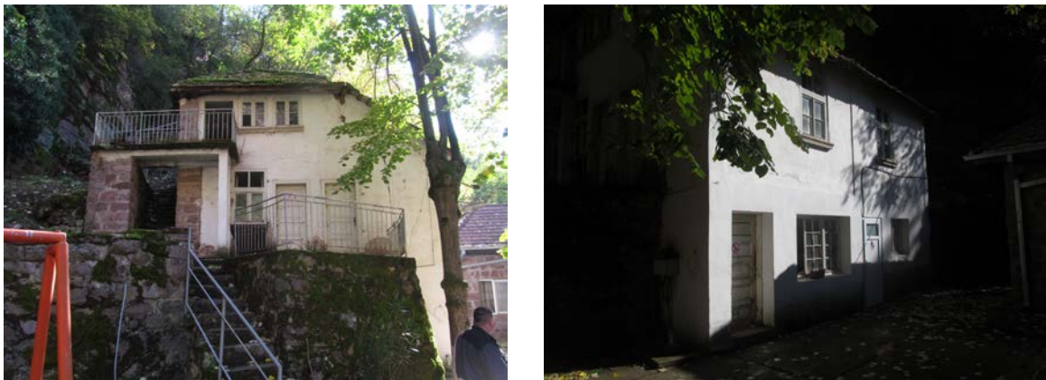
Slika 3.14. Pomoćni objekat na platou mašinske zgrade
