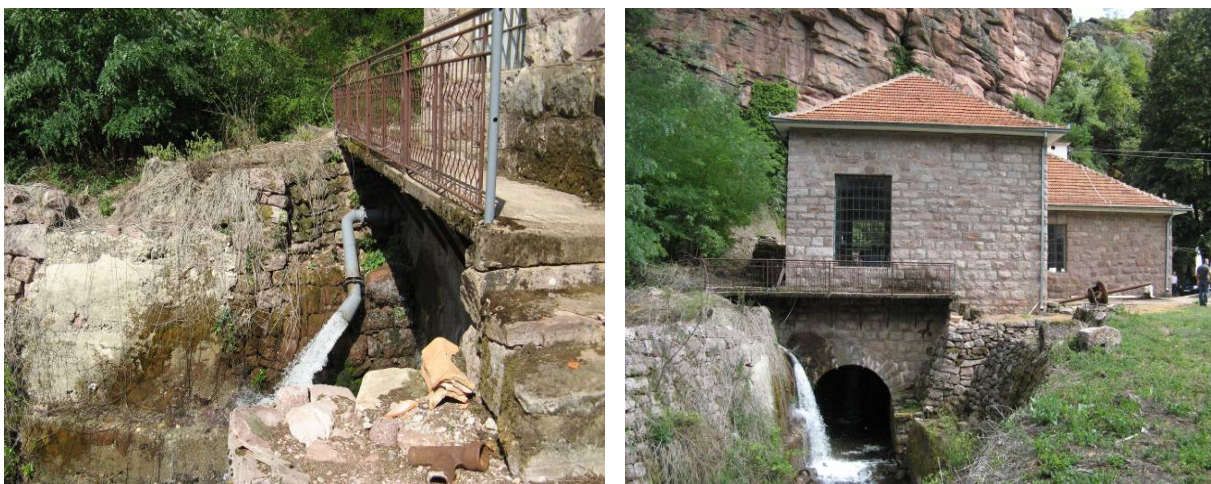
Slika 3.15. Pogled na izlaz iz odvodne vade mašinske zgrade MHE "Temac"
