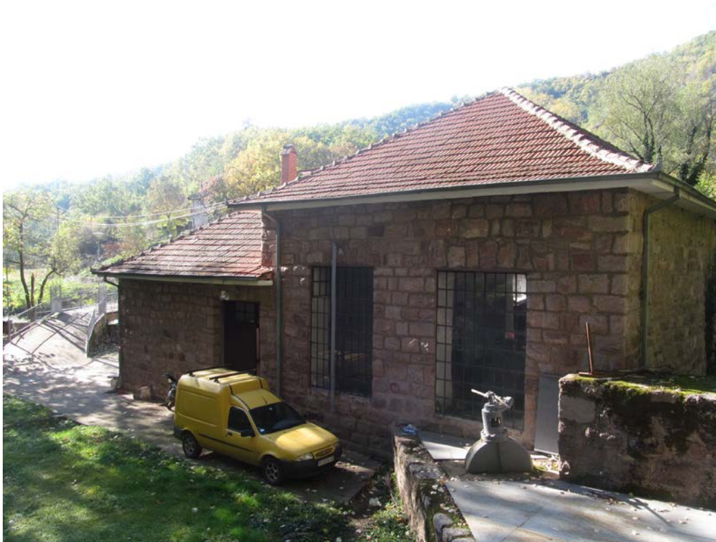
Slika 2.3 Mašinska zgrada MHE "Temac"
