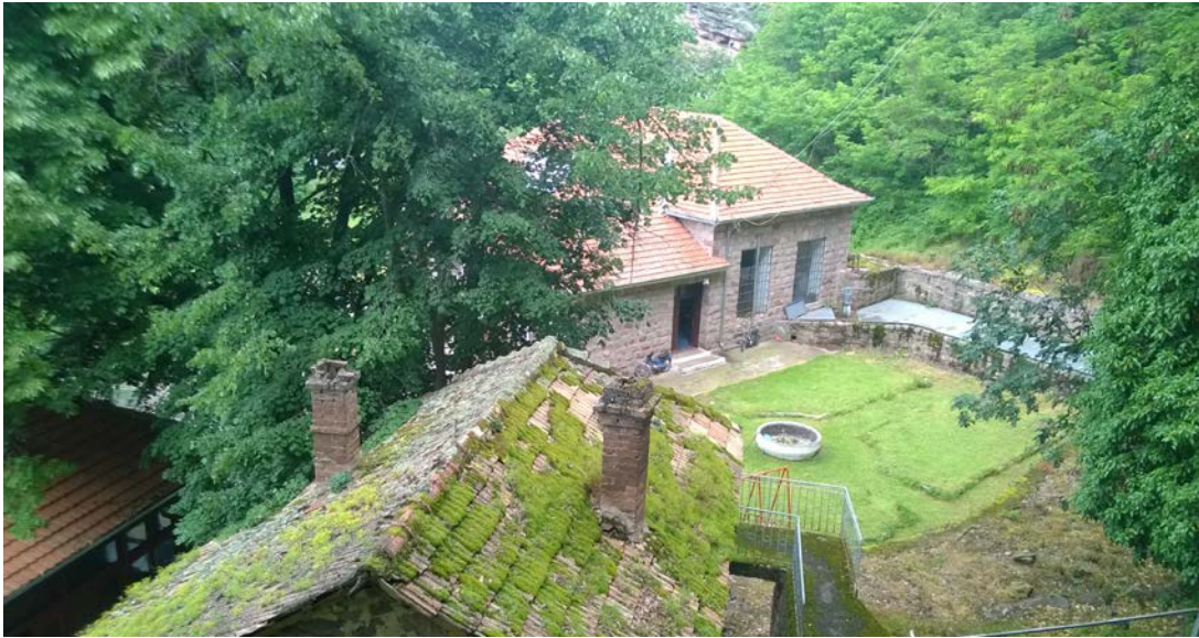
Slika 3.11 Mašinska zgrada MHE "Temac"
