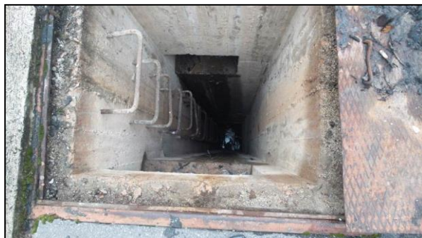
Слика 2.2: Шахт на испусту санитарне отпадне воде
