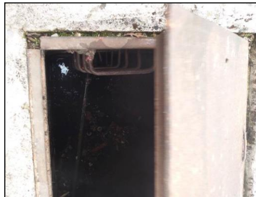
Слика 2.6: Испуст из дренажне јаме
