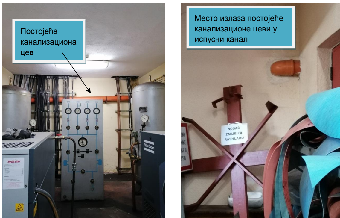
Слика 2.13: Главна канализациона цев – место излаза из машинске зграде у испусни канал
