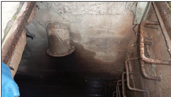
Слика 2.6: Испуст из дренажне јаме
