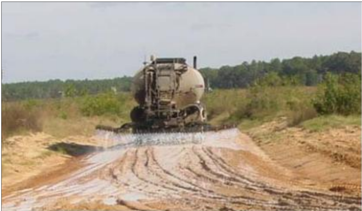
Слика бр. 28: Обарање прашине аутоцистернама (Извор: Google Images)
