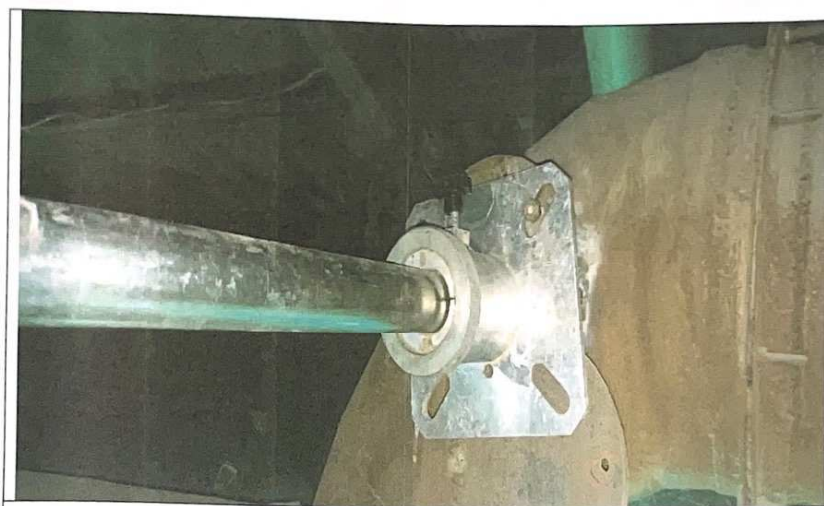
Položaj mernog mesta na dimovodnom kanalu kotla
