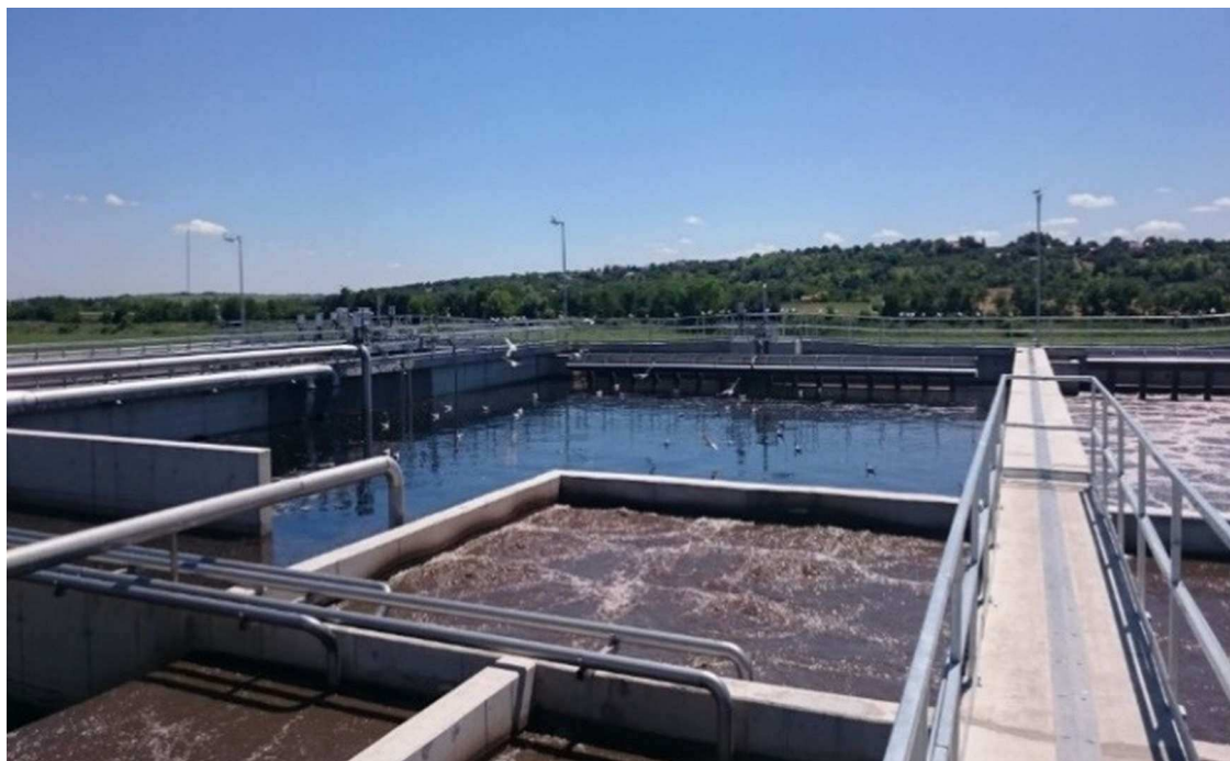
Слика бр.10. Изглед реактора за биолошки третман - Правоугаони ContiSek
