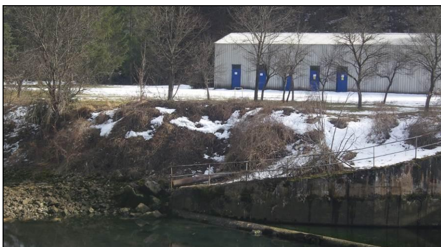
Слика 6: Испуст из дренажног бунара
