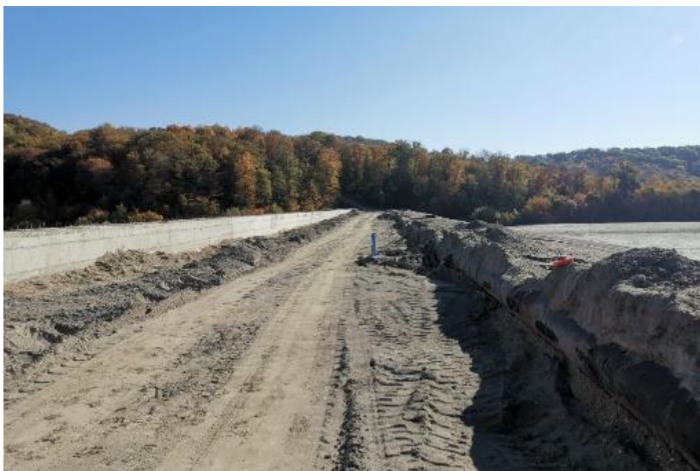
Слика 3.20. Поглед на круне бране Превој Шашка на коти K+537 mпн и ново уграђени пијезометар, 2019.
