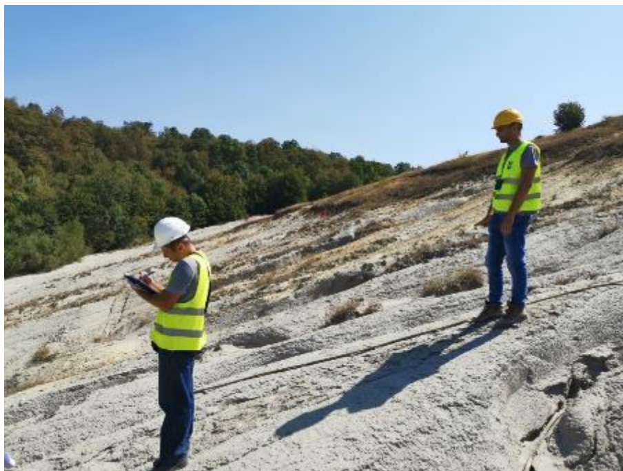
Слика 3.12. Дејство ерозије воде и ветра на спољашњу косину бране, септембар 2019. године
