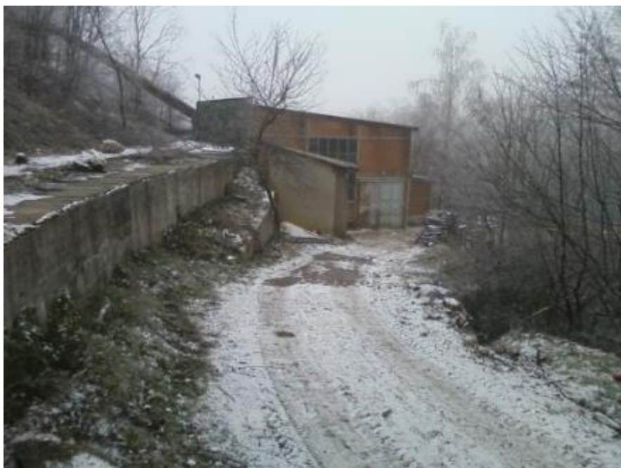
Слика 3.4. Пумпна станица ПС2
