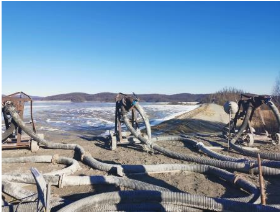
Слика 3.16. Поглед са круне бране Калуђерица у правцу започетог надвишења бране „Пустуњац“
