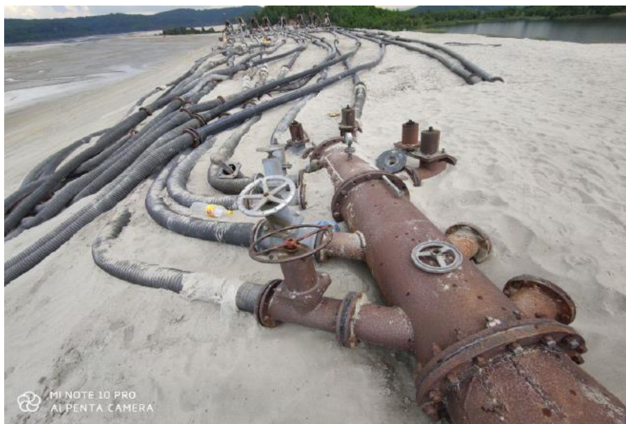
Слика 3.23. Начин повезивања ХЦ на дистрибутере пулпе на флотацијском јаловишту „Ваља Фундата“, снимљено јуна 2020. године
