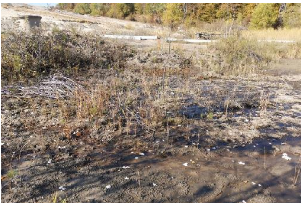
Слика 3.21. Фронт процеђивања на спољашњој косини Певој Шашка
