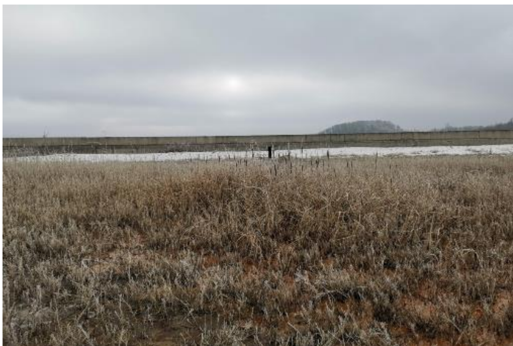
Слика 3.17. Поглед са спољашње косине бране Пустинџац у правцу бетонске бране, 2020. год.
