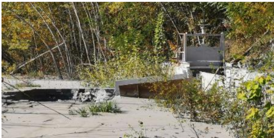
Слика 3.7. Испуст на бетонском каналу након бране Ванчев поток
