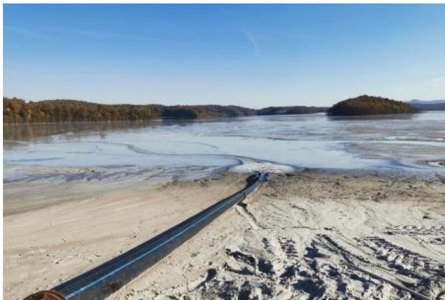
Слика 3.9. Одлагање муља и формирање плаже, 18.10.2019.
