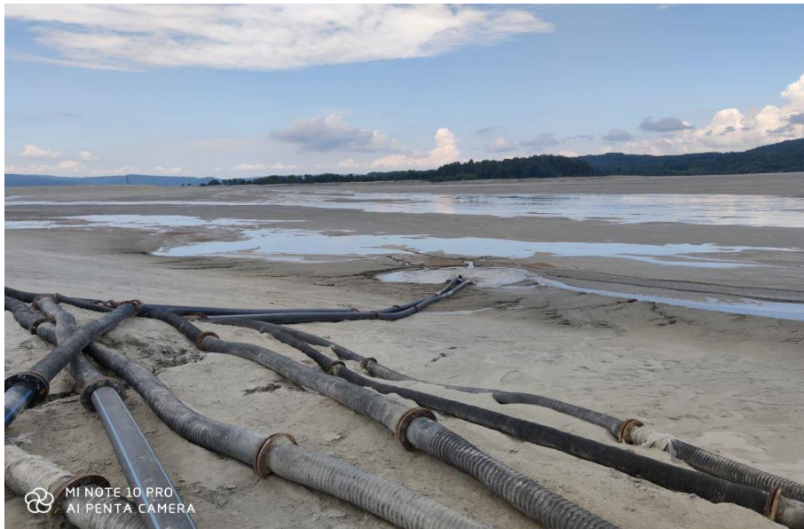
Слика 3.25. Одлагање муља хидроциклона иза фронта напредовања бране, брана Пустуњац 1, јун 2020. године
