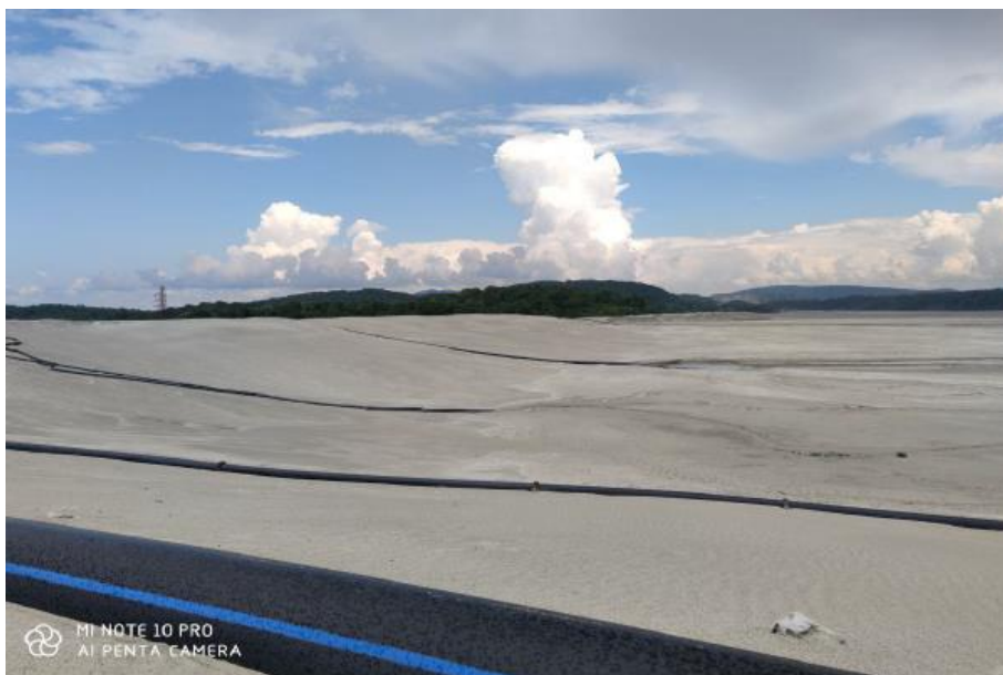
Слика 3.26. Истакачи за одржавање ширине плаже испред бране Калуђерица, јун 2020. год.
