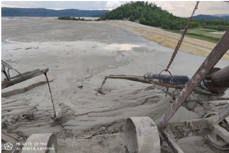
Слика 3.24. Типичан пример директне уградње песка, ХЦ на брани Пустињац 1, снимљени у раду јуна 2020. године
