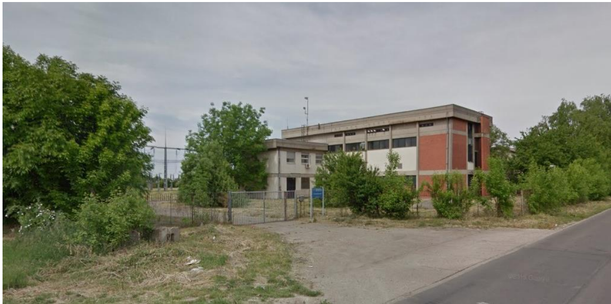
Слика 2-3 : Трансформаторска станица ТС 110/35 kV „Београд 9“
