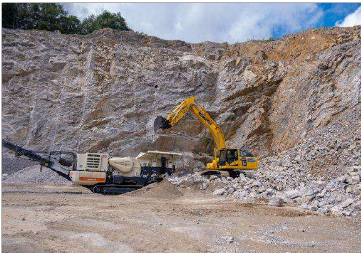
Slika br. 21 – Mobilno drobilično postrojenje METSO LOKOTRACK LT 96 u radu
