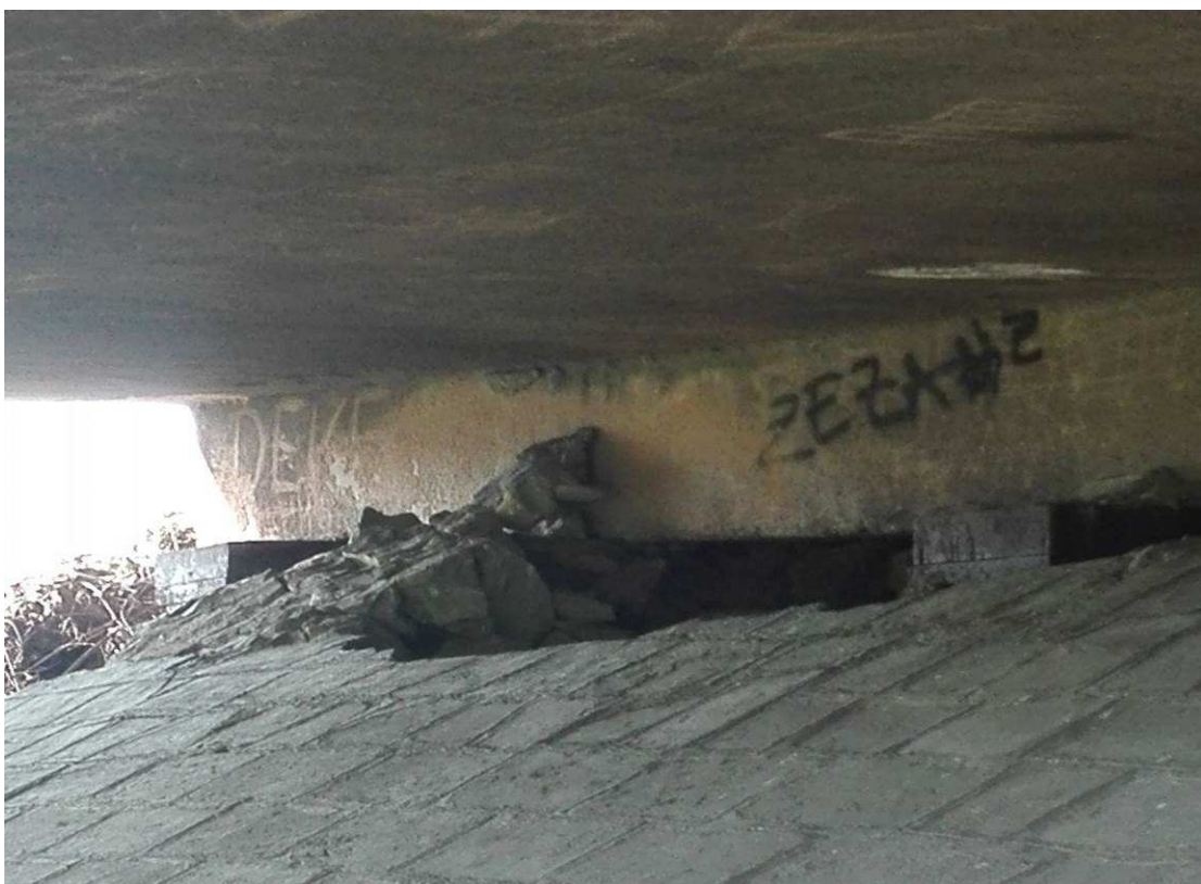
Слика 14: Лежишта на крајњем стубу ка Добановцима
