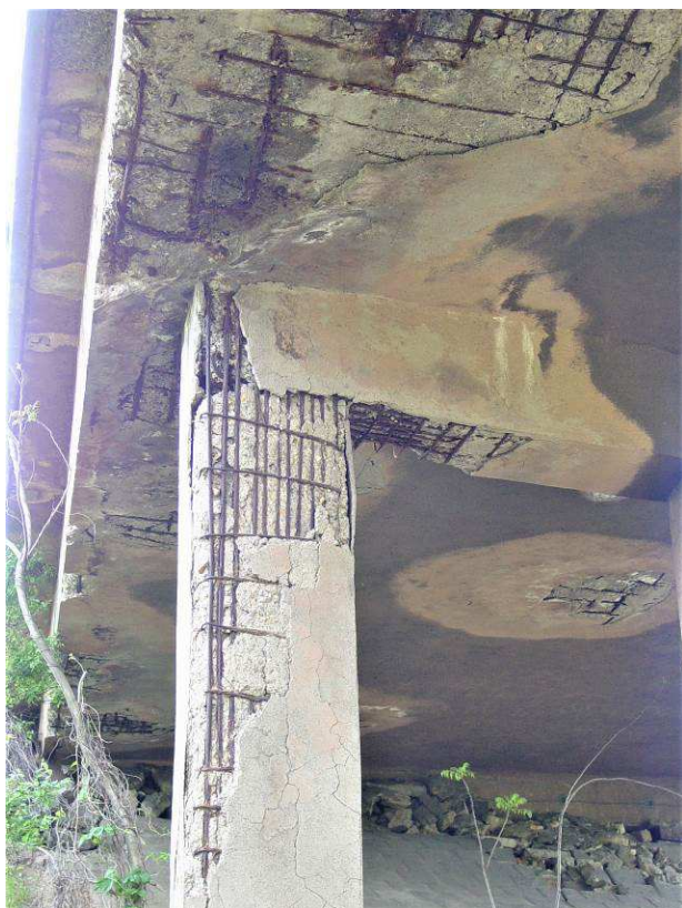
Слика 3 и 4: Оштећења средњег стуба бр.2 и бр.3. и попречних носача
