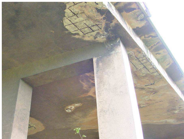
Слика 7 и 8: Оштећења вишег дела коловозне плоче и испод контактне мреже
