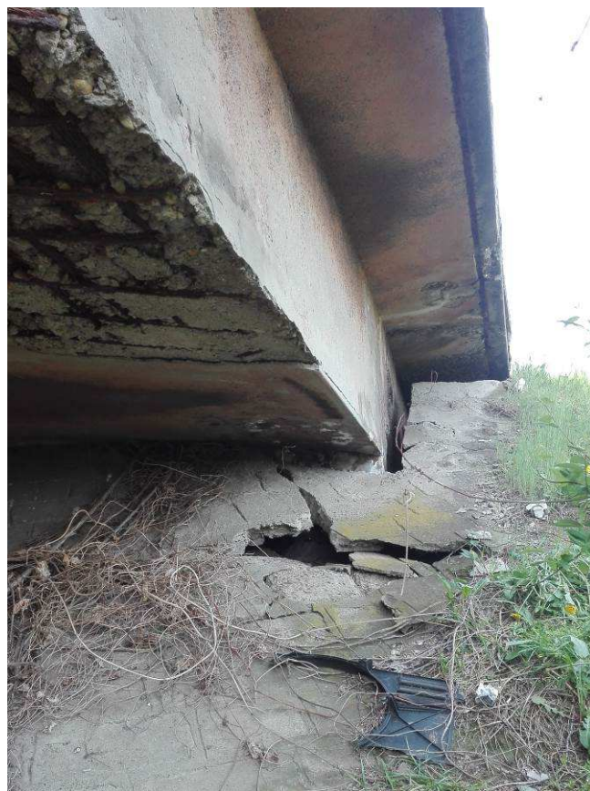
Слика 9 и 10: Оштећења плоче моста и облоге пропуштеног насипа ка Добановцима
