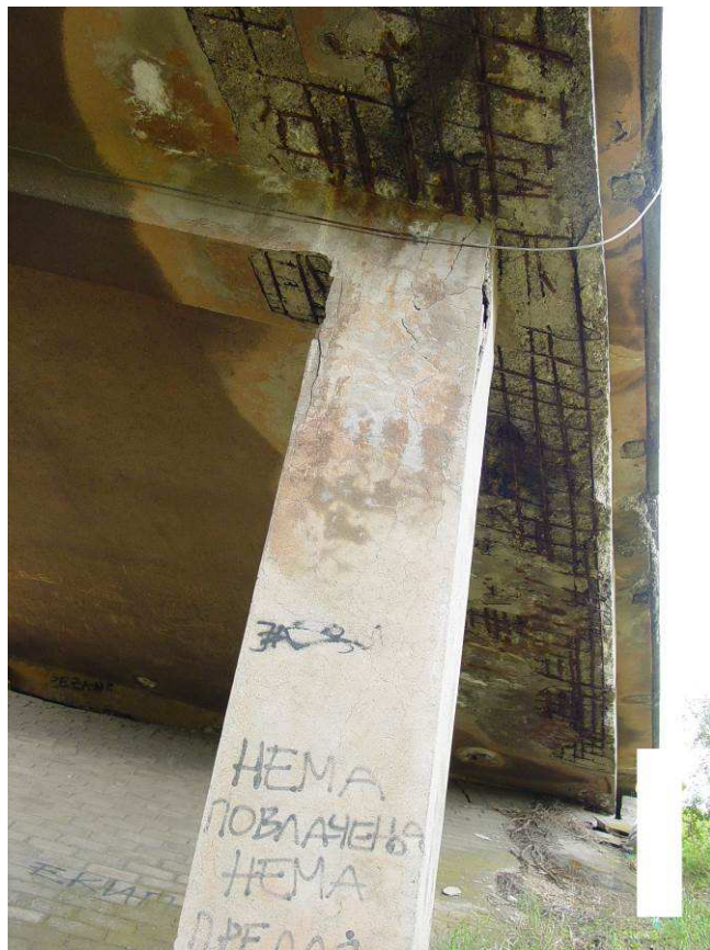
Слика 5 и 6: Оштећења нижег дела коловозне плоче
