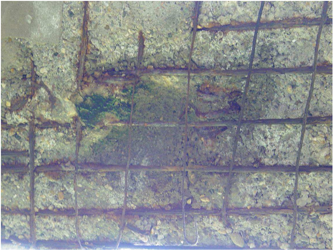
Слика 11: Кородирана арматура доње ивице коловозне плоче, недостаје бетон изнад главне арматуре
