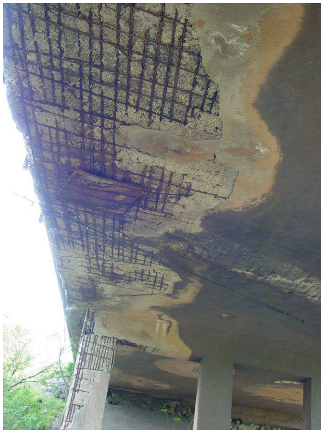
Слика 5 и 6: Оштећења нижег дела коловозне плоче
