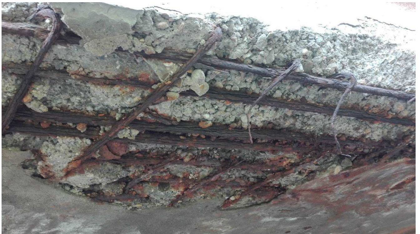
Слика 12: Кородирана арматура доње ивице коловозне плоче
