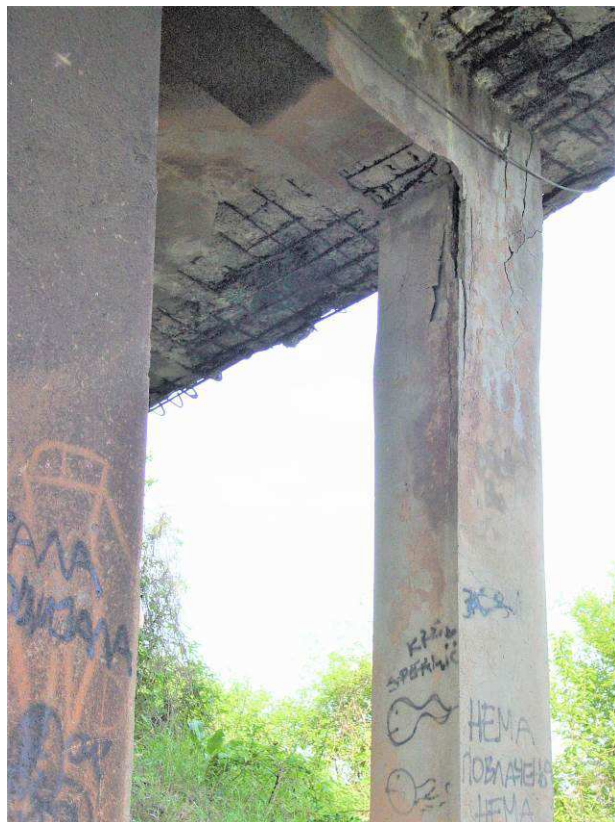
Слика 3 и 4: Оштећења средњег стуба бр.2 и бр.3. и попречних носача
