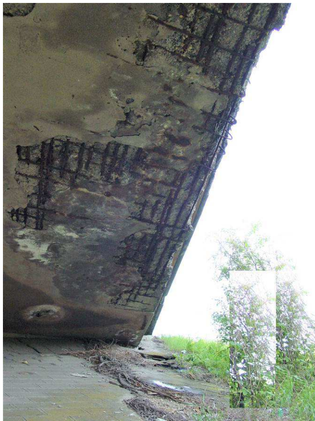
Слика 9 и 10: Оштећења плоче моста и облоге пропуштеног насипа ка Добановцима
