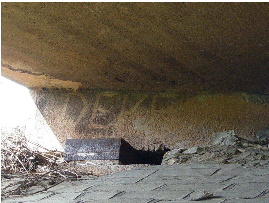
Слика 13: Лежишта на крајњем стубу ка Добановцима
