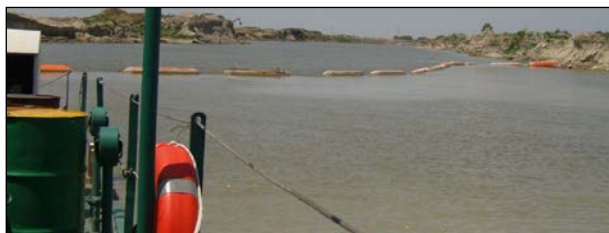
Slika 11: Cevovod za transport peska
