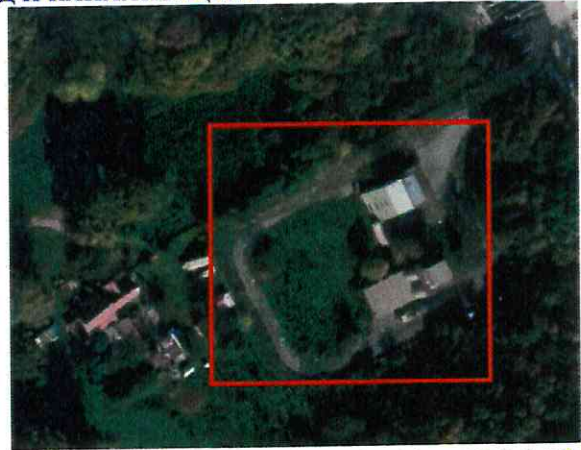
Слика 2: локација постојећег постројења ВТР ГАУ
