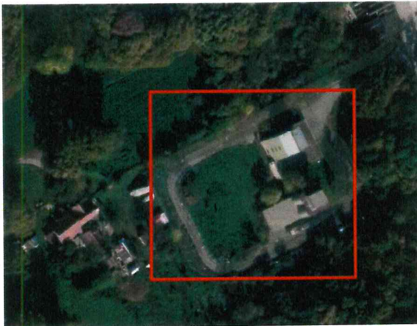
Локација постојећег постројења ВТР ГАУ
