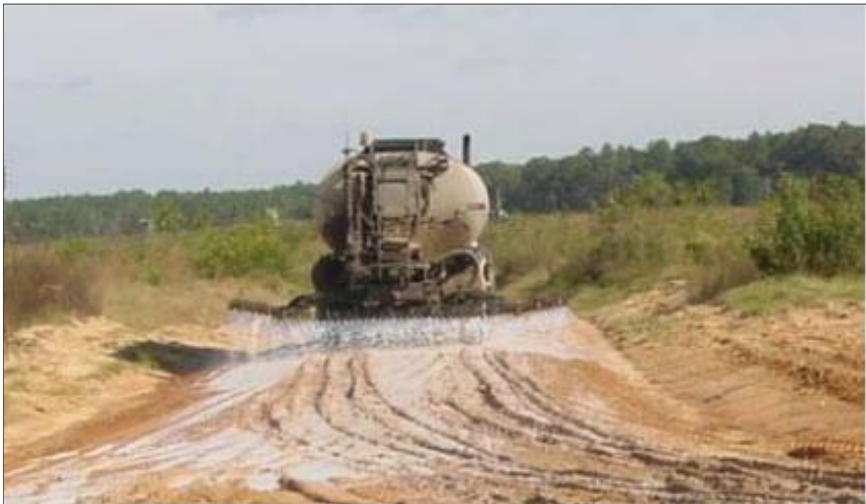
Слика бр. 21: Обарање прашине аутоцистернама (Извор: Google Images)
