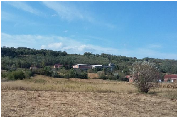
Слика бр. 6: Фабрика за производњу воде за пиће у Мајдеву - поглед са Државног пута 1Б реда бр. 38
