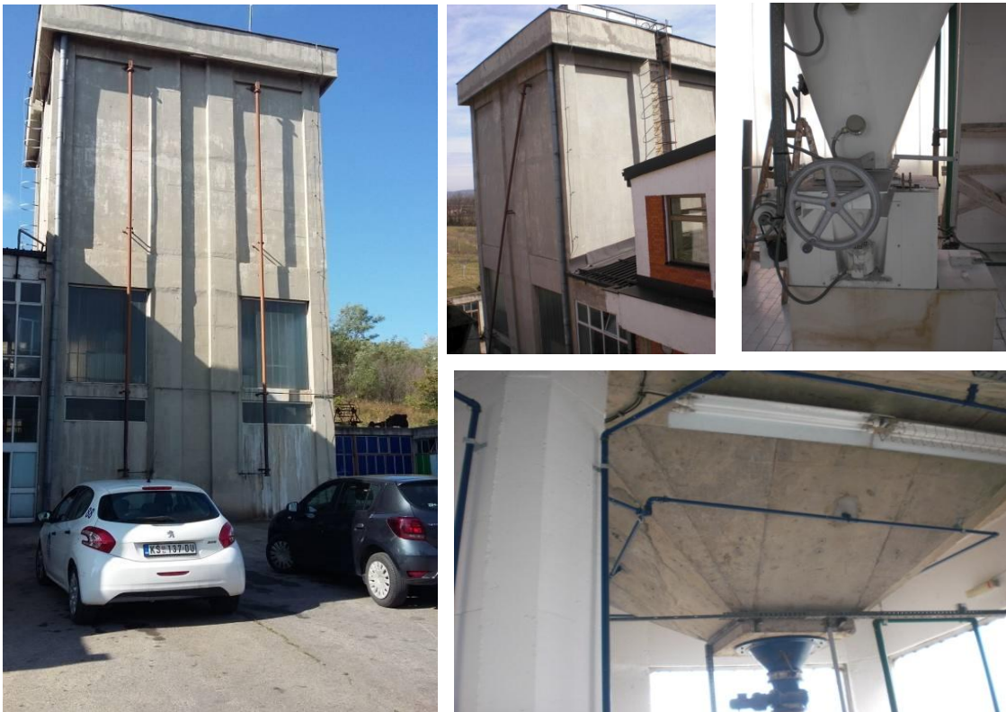
Слика бр. 31: Објект складишта алуминијум сулфата и дозирни уређај за алуминијум сулфат
