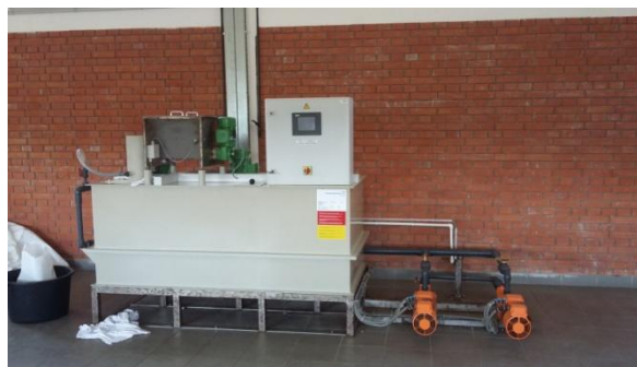
Слика бр. 26: Уређај за припрему и дозирање полиелектролита
