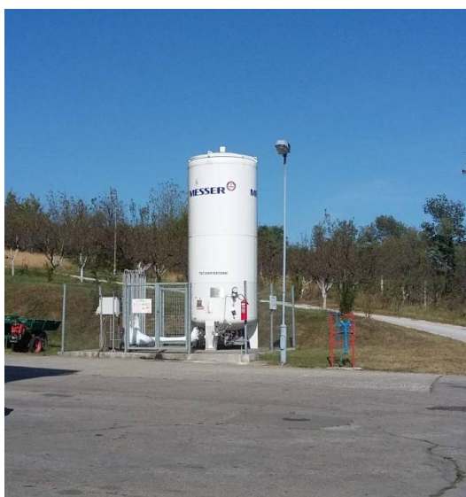
Слика бр. 29: Гасна станица течног кисеоника
