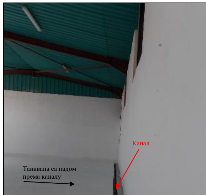
Слика 35. – Канал за прихват евентуално изливених уља у складишту опасног отпада
