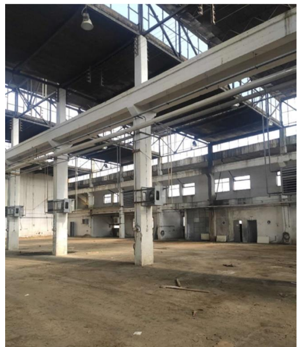
Slika 2.1 – Unutrašnjost objekta br. 31 sa krovnom konstrukcijom i kranskom stazom
