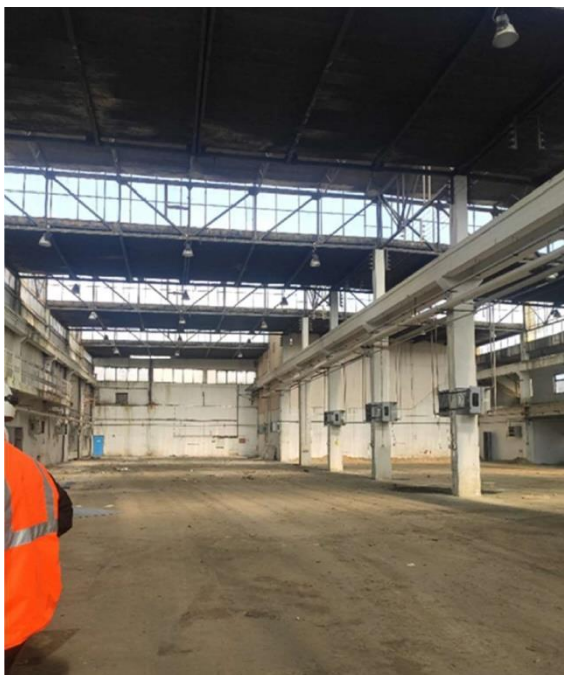
Slika 2.1 – Unutrašnjost objekta br. 31 sa krovnom konstrukcijom i kranskom stazom
