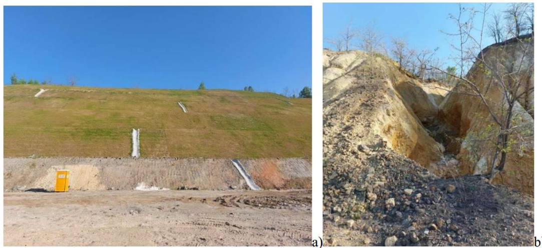
Slika 2.11. Sanirana kosina u nasipu (a), jaruga u nesaniranom delu kosina (b)
