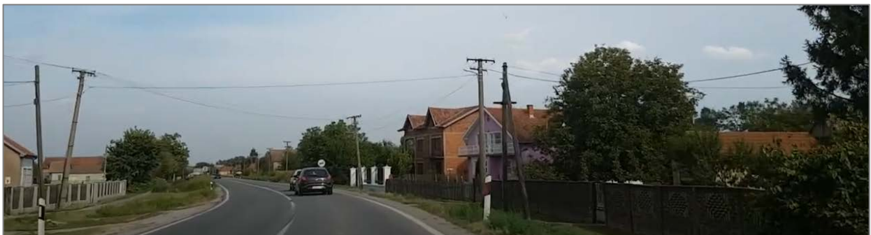
Слика 34 - Објекти на истражном подручју уз постојећу саобраћајницу
