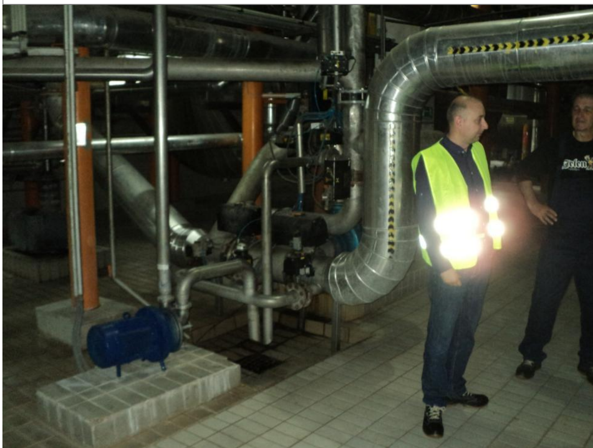
Slika 100: Cevovod za transport komine
