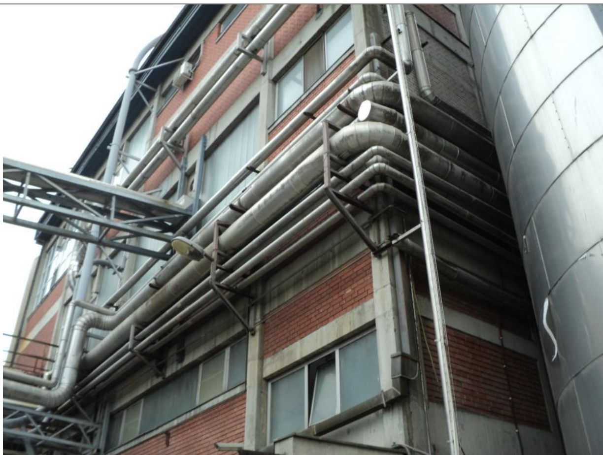
Slika 14: Glavna parna cev od kotlarnice ka varioni
