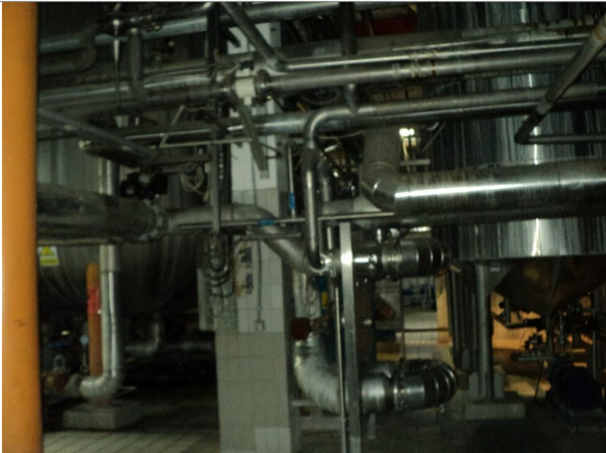
Slika 12: Cevovod dovoda pare za kotao sladovine 1
