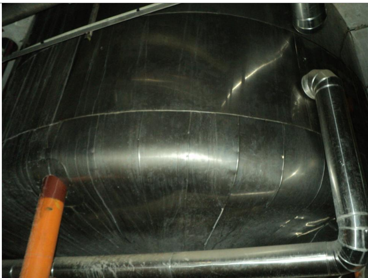
Slika 13: Cevovod dovoda pare za komovnjak 1
