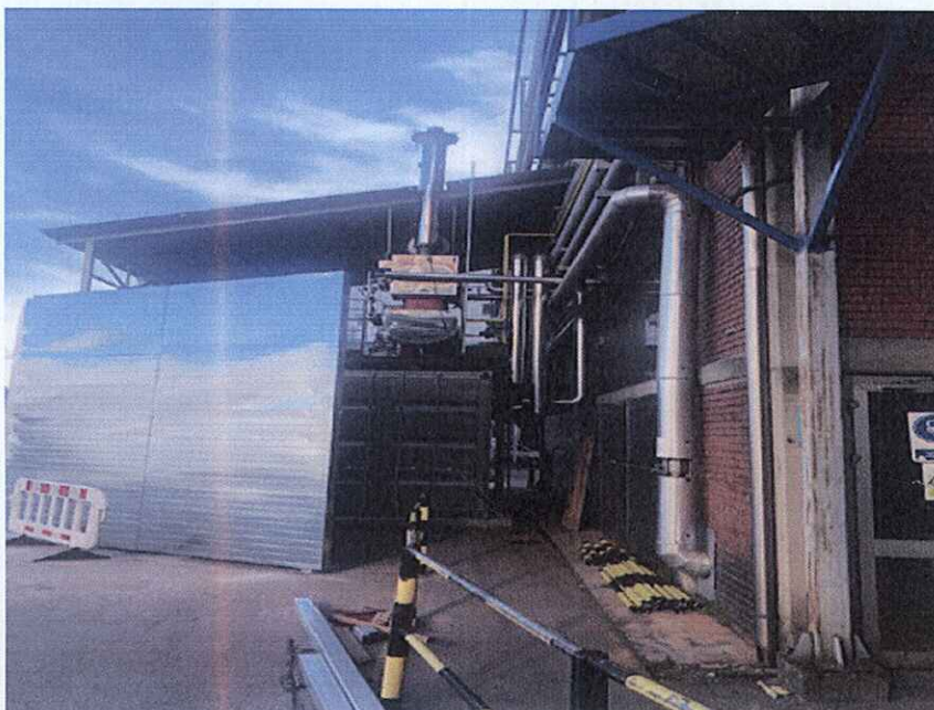
Slika br.2: Kogenerator u APA - izvor specifične buke
