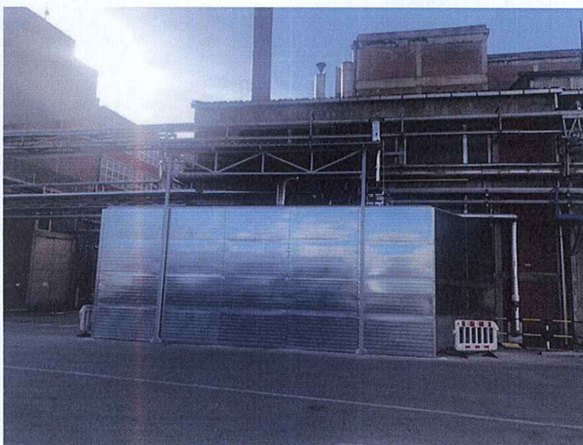
Slika br.3: Kogenerator sa zvučnom barijerom kao izvor specifične buke APA
