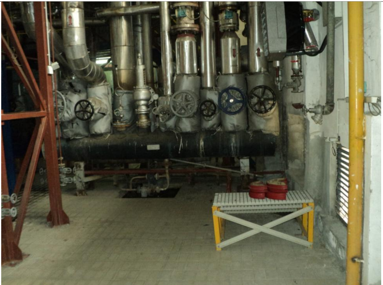
Slika 17: Glavna parna baterija – razdelnik pare
