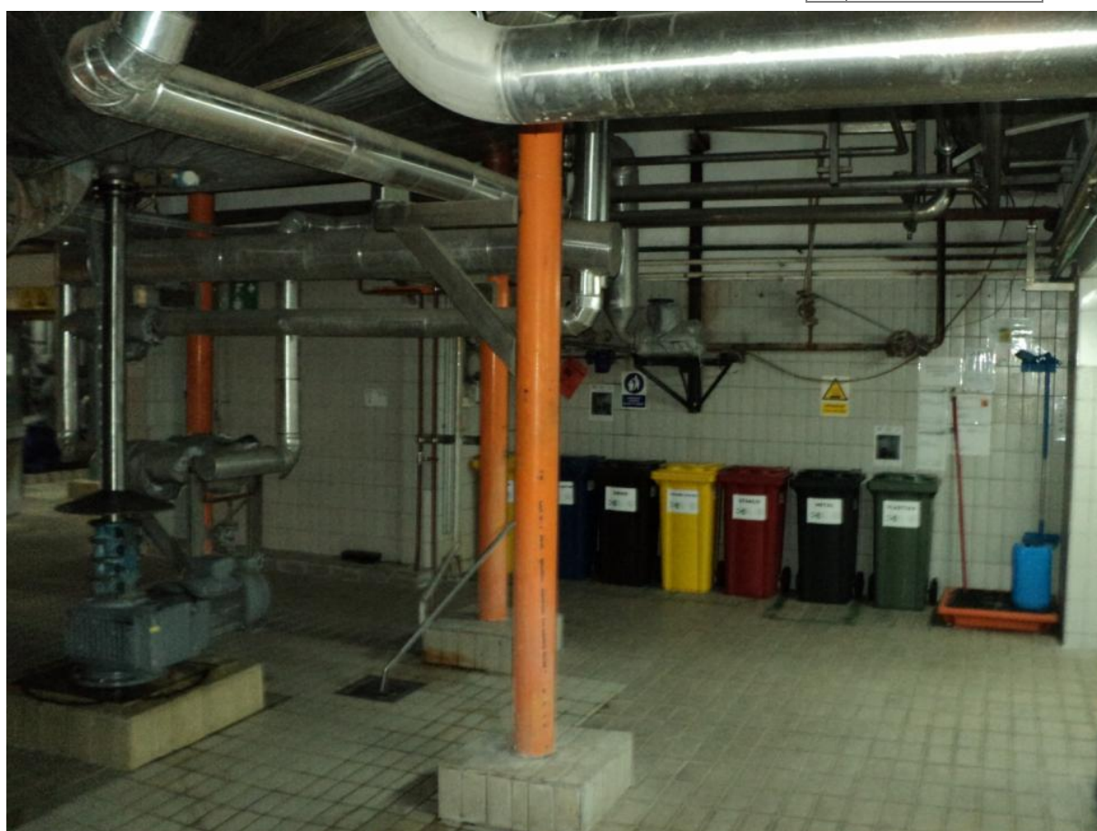
Slika 11: Cevovodi za povrat kondenzata i cevovod dovoda za komovljak 1
