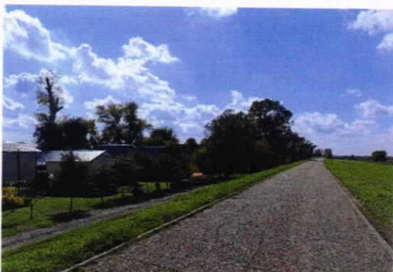
Слика 6.– Постојећа сервисна саобраћајница по круни насипа
